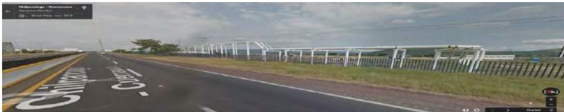
Fig. 135 Fotografía del terreno desde la carretera Federal vista Oeste, fuente Google Map®.
