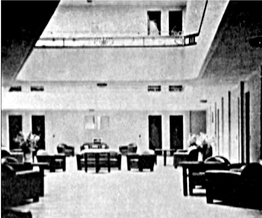
Imagen 3.17 Vista del patio interior en el cuarto piso cuando tenía muebles
