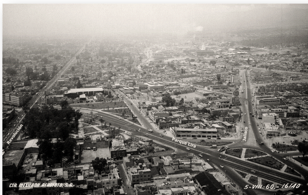
Imagen 4.2 Vista de la zona centro de Tacubaya 1960
