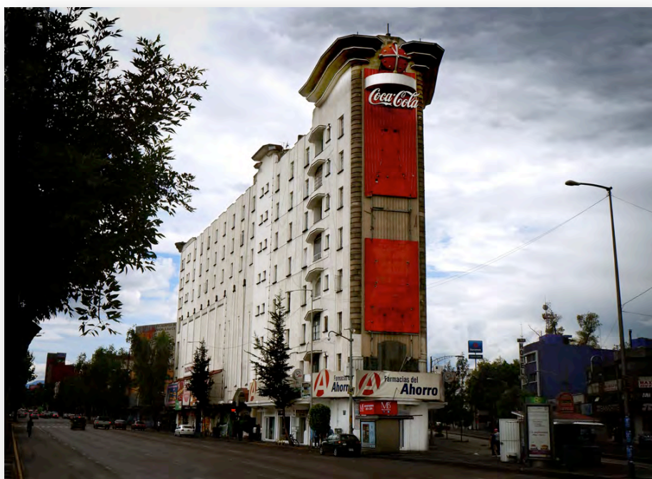
Imagen 3.12 Edificio Ermita visto de norte a sur
