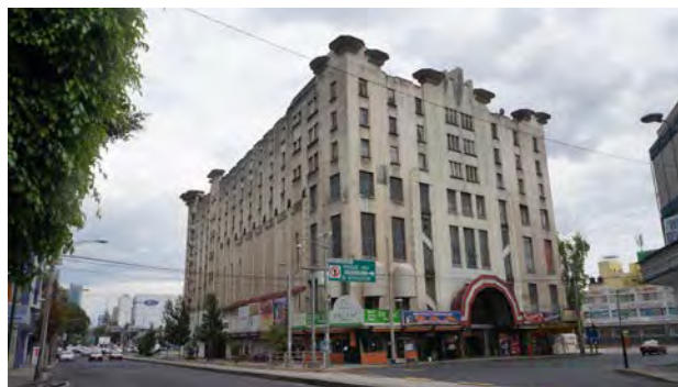
Imagen 3.15 Fachadas sobre Progreso y Av. Jalisco
