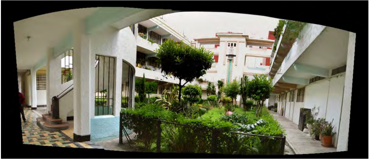
Imágenes 3.40 Vista interior del edificio Martí
