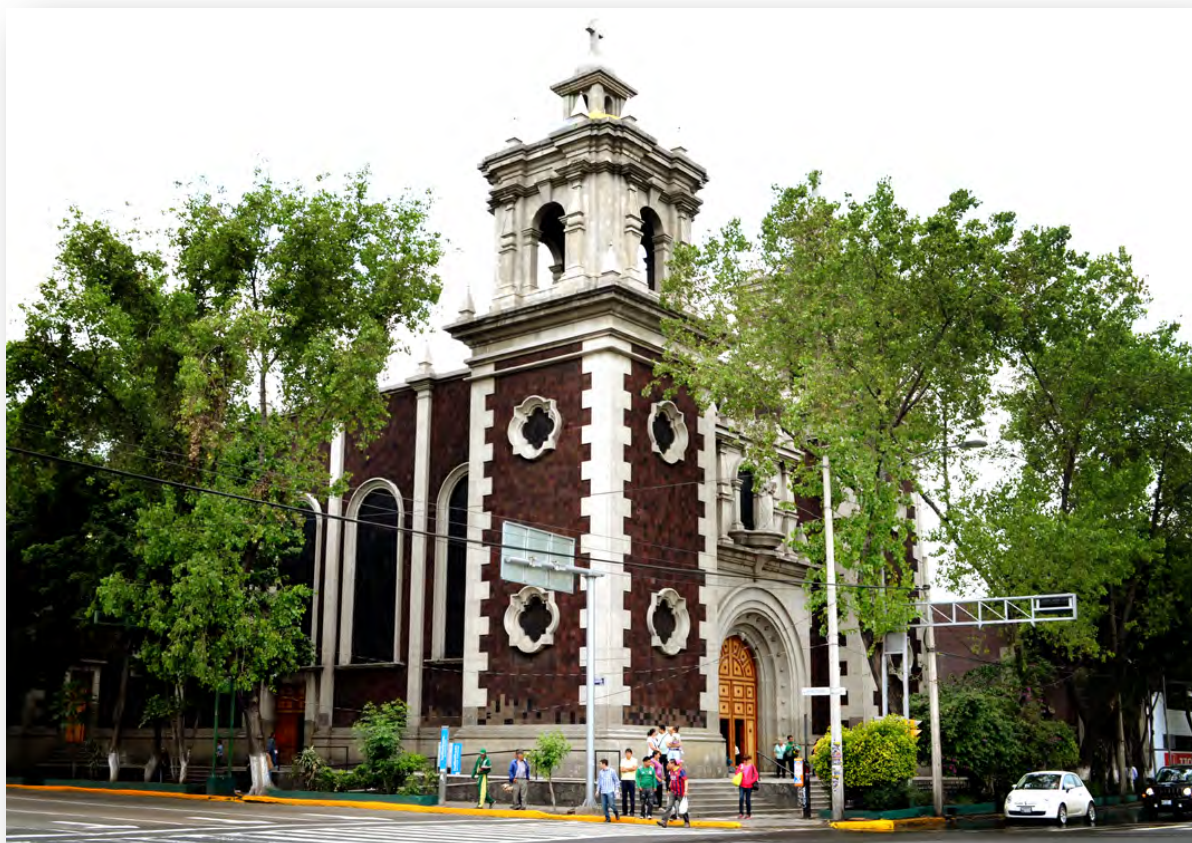
Imagen 4.3 Exterior de la parroquia. Fachada principal y lateral del templo
