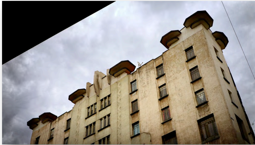
Imágenes 3.26 Fachada lateral por Av. Jalisco y remate principal desde la azotea
