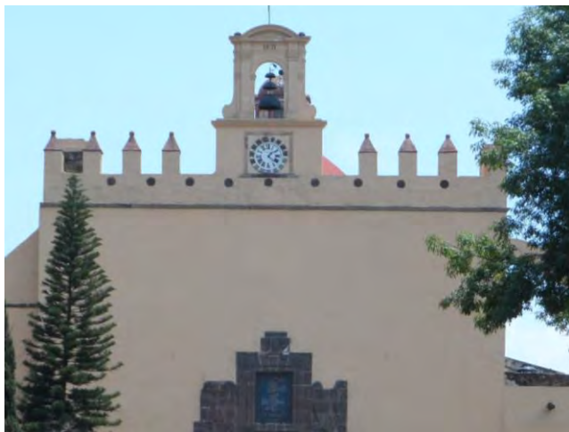
Imagen 305. Fotografía de la parte superior de la fachada principal del Templo y ex convento de San Bernardino de Siena, en la cual se aprecian las almenas, reloj, espadaña y campaniles, así como la huella del óculo con el que contaba el templo, centro Histórico de Xochimilco, julio 2012.
