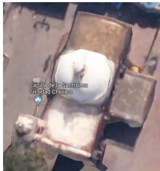
Imagen 133. Imagen aérea de la Cubierta de la Capilla de la Santísima, marzo 2014. Fuente: www.googlemaps.
