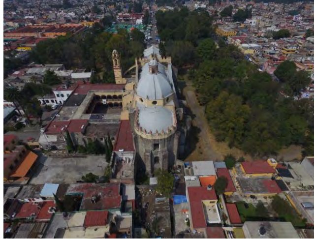
Imagen 334. Imagen aérea de la fachada Oriente del Templo y ex convento de San Bernardino de Siena, se puede apreciar el ábside, cúpula y bóveda de cañón corrido los cuales no sufrieron ningún tipo afectación por el sismo del 19 de septiembre, octubre 2017.
