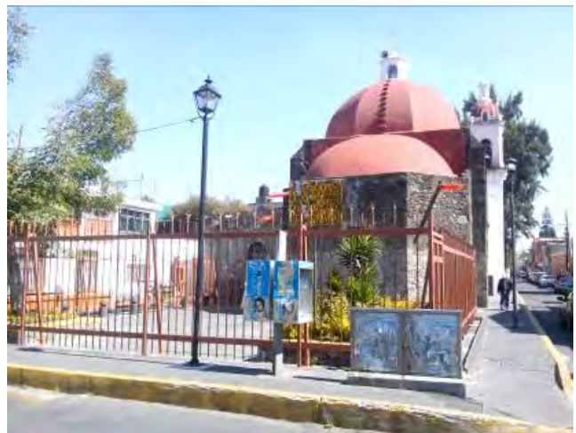
Imagen 209. Fotografía de la fachada poniente de la capilla de La Concepción, se muestran los elementos metálicos discordantes que se le han ido añadiendo a la capilla, octubre 2015.
