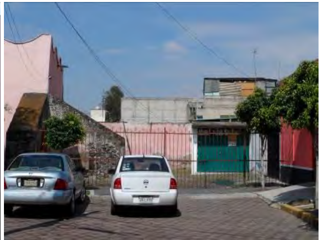
Imagen 235. Fotografía de la fachada oriente de la capilla de San Juan, se muestra la colocación de estructura metálica adosada a la fachada, así como vehículos estacionados en el perímetro de la capilla, octubre 2015.
