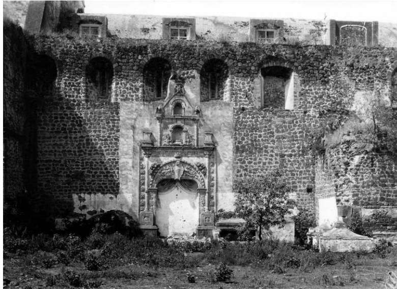
Imagen 36. Fachada Norte del Templo y ex convento de San Bernardino de Siena, Fototeca INAH, Fotógrafo no identificado 1940.
