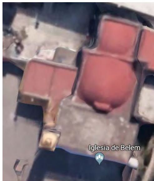
Imagen 54. Imagen aérea de la Cubierta de la Capilla de Belem, marzo 2014. Fuente: www.googlemaps.
