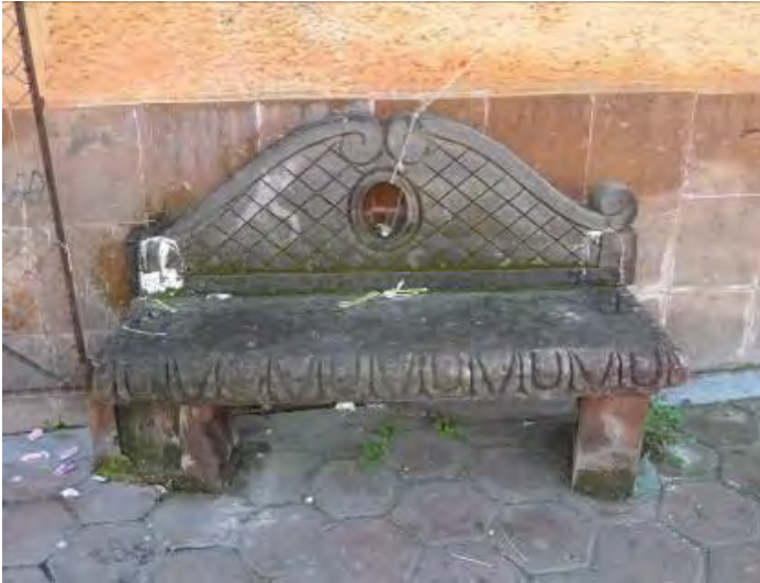
Imagen 232. Fotografía de bancas de cantera las cuales presentan un deterioro avanzado debido al intemperismo y a la falta de intervención, ubicadas en la plaza de la capilla de San Francisco Caltongo, octubre 2015.
