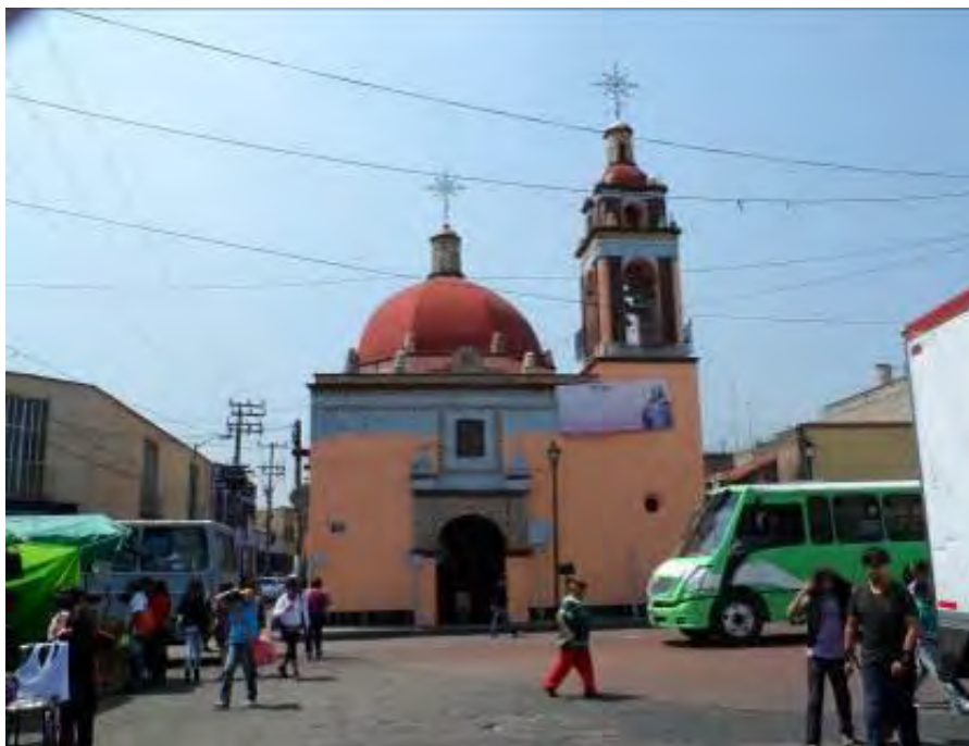
Imagen 127. Fachada de la Capilla del Rosario, octubre 2013.
