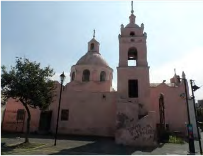
Imagen 236. Fotografía de la fachada norte de la capilla de San Juan, se muestra el deterioro que presenta debido a la pérdida de pintura, presencia de flora parasita superior e inferior, grafitis generados por el vandalismo y la colocación de elementos discordantes, octubre 2015.
