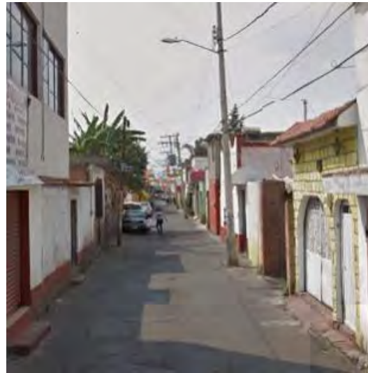
Imagen 163. Fotografía de la calle Nezahualcóyotl esquina con Violeta, en la cual se observa que la calle no cuenta con banqueta, centro Histórico de Xochimilco, octubre 2015.
