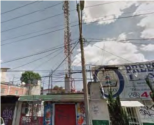
Imagen 186. Fotografía en la cual se muestra la mala imagen urbana que es causada por el exceso de cableado eléctrico aéreo en la Av. 16 de septiembre casi esquina con Camino a Nativitas, centro Histórico de Xochimilco, octubre 2015.
