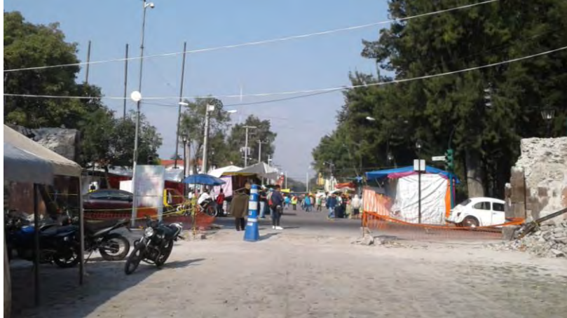
Imagen 320. Fotografía del espacio que ocupaba la Arcada Real del Templo y ex convento de San Bernardino de Siena, tomada del atrio hacia la calle, la cual colapso a consecuencia del sismo del 19 de septiembre, octubre 2017.
