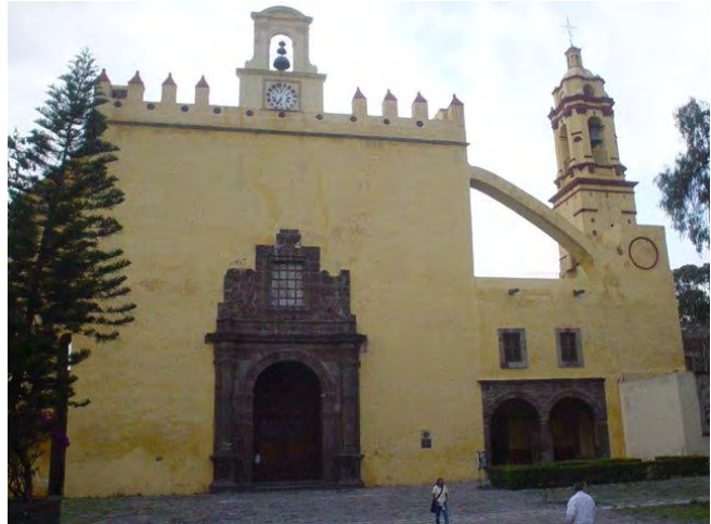
Imagen 322. Fotografía de la fachada principal del Templo y ex convento de San Bernardino de Siena, centro Histórico de Xochimilco, octubre 2005.
