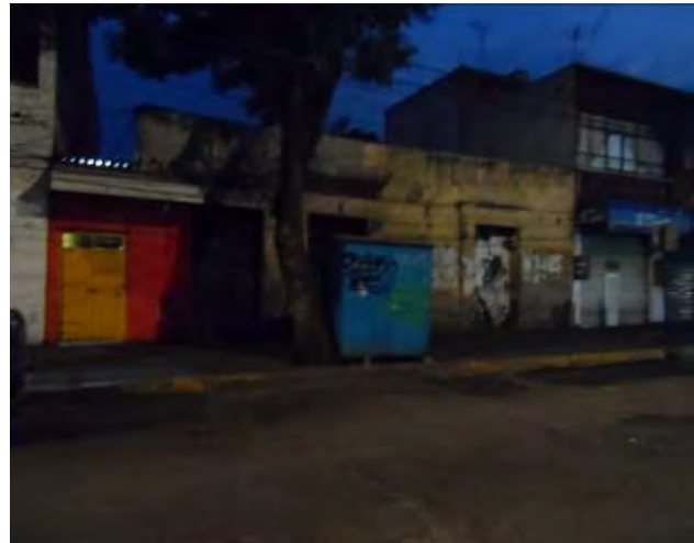
Imagen 174. Fotografía de fachada de casa con un grado de deterioro mayor, el cual se ubica en la calle Francisco I. Madero entre Av. 5 de mayo y Violeta, centro Histórico de Xochimilco, octubre 2015.
