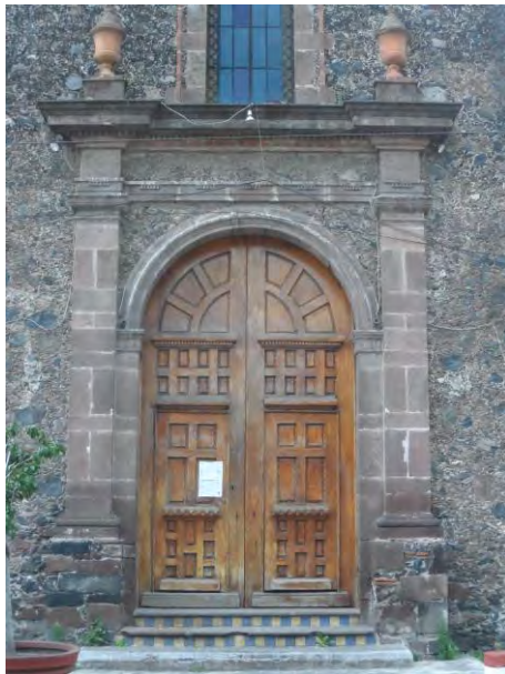
Imagen 68. Portada principal de la Capilla de San Cristóbal, octubre 2013.
