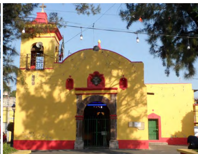
Imagen 283. Fotografía de la fachada de la Capilla de San Antonio, cuatro años después se observa que ha recibido mantenimiento, se cambió el color de la fachada, se retiró el adorno de madera que tenía en la fachada y en la torre de campanario se colocó una bocina y un barandal metálico, octubre 2017.
