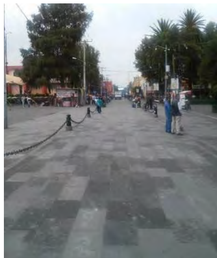
Imagen 267. Fotografía de la calle Guadalupe I. Ramírez, de Oriente a Poniente, rehabilitada en 2013 para circulación controlado. Octubre 2014.
