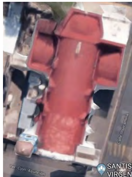
Imagen 48. Imagen aérea de la Cubierta de la Capilla de la Asunción, marzo 2014. Fuente: www.googlemaps .
