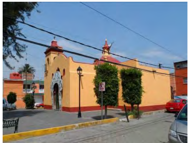
Imagen 199. Fotografía de la fachada sur de la capilla de San Antonio, en la cual se muestra la existencia de bandera y bocina colocada en la linterna de la capilla, así como el tipo de luminarias que se utilizan para iluminarla, octubre 2015.
