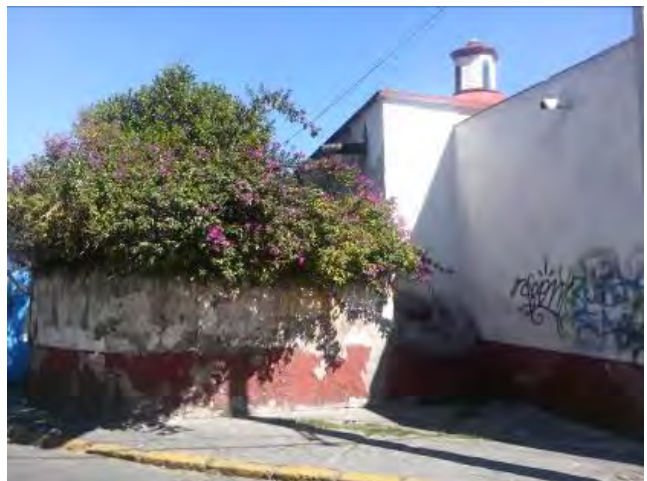
Imagen 249. Fotografía de la fachada poniente de la capilla de San Pedro, se muestran elementos que se le han añadido (construcción de barda adosada a la capilla), octubre 2015.
