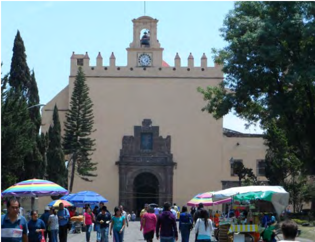
Imagen 303. Fotografía de la fachada principal del Templo y ex convento de San Bernardino de Siena, en la cual se aprecian todos los elementos que conforman la fachada principal, centro Histórico de Xochimilco, julio 2012.
