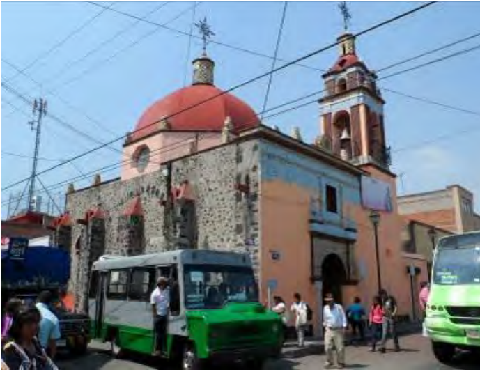
Imagen 254. Fotografía de la fachada Principal de la capilla del Rosario, se muestra el tipo de Luminaria existente que se utiliza para iluminar la capilla, así mismo, se observa la gran cantidad de líneas aéreas que pasan cerca de la capilla, octubre 2015.
