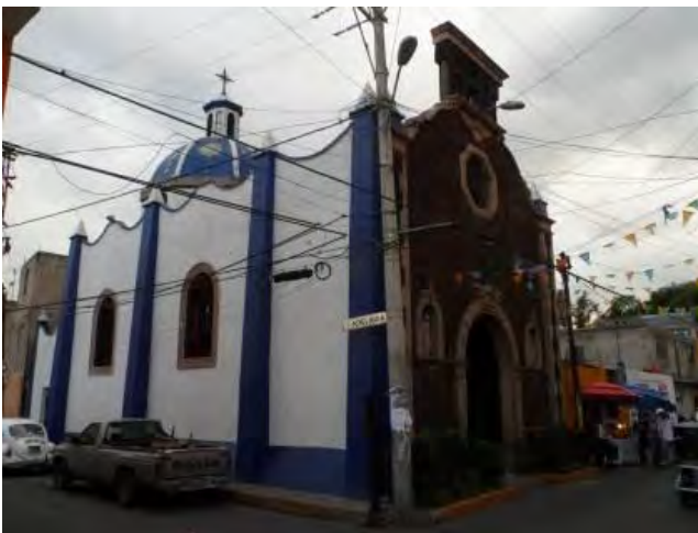
Imagen 238. Fotografía de la fachada principal y norte de la capilla de San Lorenzo, se muestra como las líneas de energía eléctrica aéreas convergen en un poste de concreto ubicado a un costado de la fachada principal, octubre 2015.
