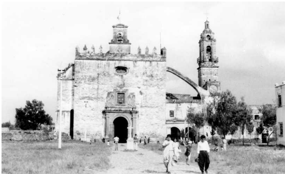
Imagen 35. Fachada del Templo y ex convento de San Bernardino de Siena, Fototeca INAH, Manuel Ramos 1925.
