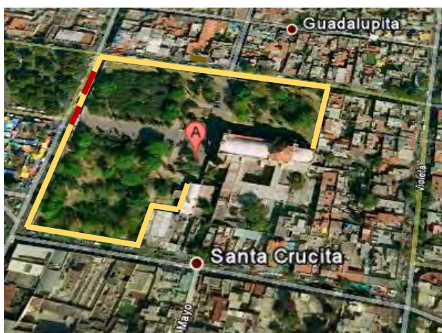
Imagen 301. Imagen aérea del perímetro del Templo y ex convento de San Bernardino de Siena, se observa en amarillo la barda atrial y en rojo las zonas que fueron afectadas (arcada real y barda atrial), Fuente: www.googlemaps octubre 2017.
