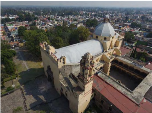
Imagen 309. Fotografía aérea en perspectiva del Templo y ex convento de San Bernardino de Siena, se aprecia la torre del campanario sin la linternilla ni la cruz metálica que colapsaron a consecuencia del sismo, de igual manera, se observa el arco botarel, bóveda de cañón corrido, tambor de cúpula, cúpula, linternilla y claustro, los cuales no presentan afectación, octubre 2017.
