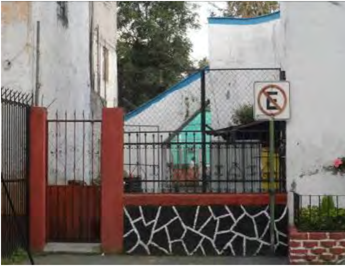
Imagen 202. Fotografía lateral izquierda de la fachada principal de la capilla de La Asunción, se muestran elementos de tabique y de herrería que se le han ido añadiendo a la capilla, octubre 2015.
