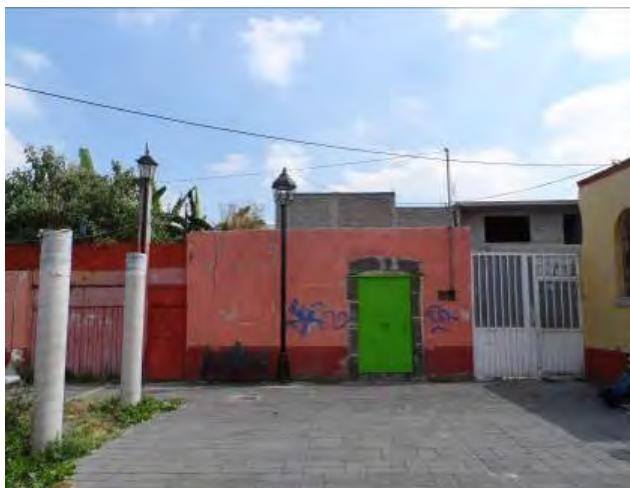
Imagen 204. Fotografía de la parte lateral de la fachada norte de la capilla de Belem, en la cual se muestra como el propietario de la casa colindante se apropió de la parte posterior de la capilla, lo anterior construyendo un muro y colocando un zaguán adosado a la capilla, octubre 2015.
