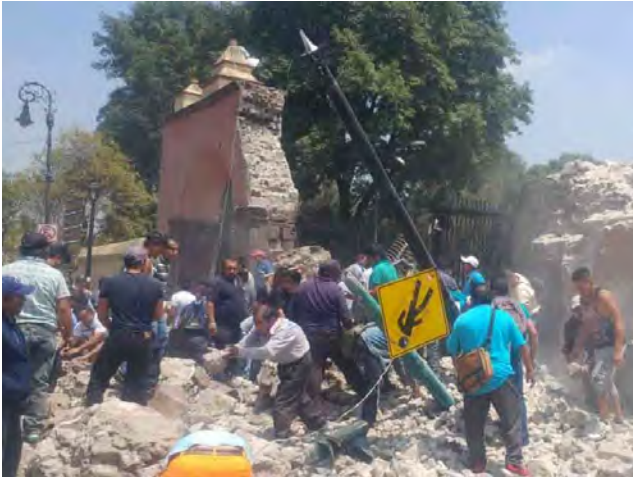
Imagen 281. Fotografía del Universal donde se muestra el colapso de la Arcada Real del Templo y ex convento de San Bernardino de Siena, se muestra un grupo de personas que en su afán de ayudar a buscar gente atrapada bajo los escombros de la arcada real, movieron los escombros de una manera desorganizada, asimismo, se aprecia como uno de los tres arcos que formaban la arcada real no sufrió colapso, centro Histórico de Xochimilco, septiembre 2017.
