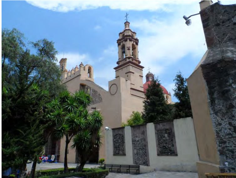
Imagen 34. Torre de campanario y arco botarel del templo y ex convento de San Bernardino de Siena, centro Histórico de Xochimilco, julio 2012.
