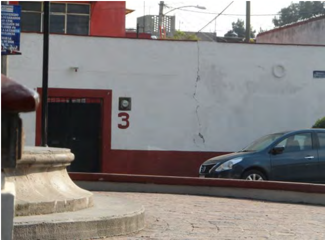
Imagen 277. Fotografía en la cual se muestra el daño que presenta la barda de la casa a consecuencia del sismo del 19 de septiembre, plaza de la capilla de San Cristóbal, octubre 2017.
