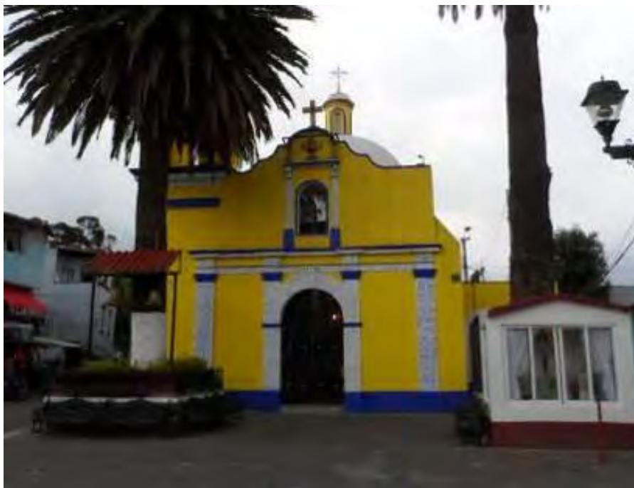
Imagen 134. Fachada de la Capilla de la Santísima, octubre 2013.
