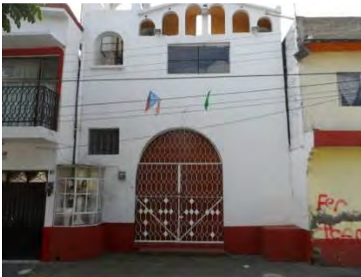
Imagen 95. Fachada de la Capilla de la Guadalupe, noviembre 2013.
