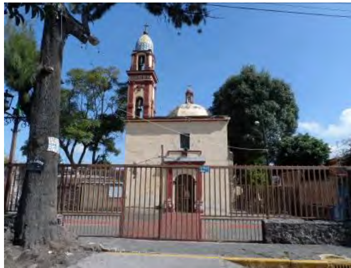
Imagen 247. Fotografía de la fachada principal de la capilla de San Marcos, se muestran elementos de herrería colocados para restringir el acceso a la plaza de la capilla, octubre 2015.
