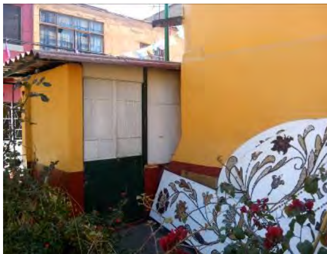
Imagen 196. Fotografía de la fachada nor-oriental de la capilla de San Antonio, se muestra un cuarto de tabique de recién construcción el cual está añadido a la capilla, octubre 2015.
