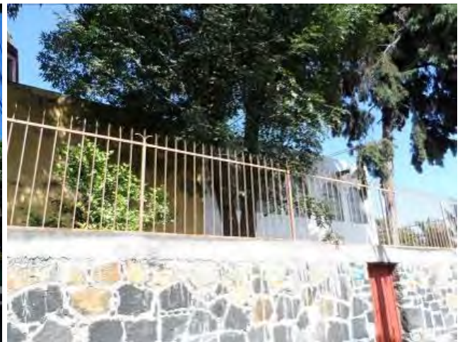
Imagen 245. Fotografía de la fachada sur de la capilla de San Marcos, se muestran los elementos que se le han añadido, así como la ampliación que se le realizó a la capilla, octubre 2015.
