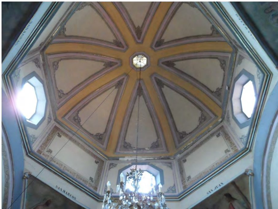
Imagen 129. Detalle de la cúpula vista desde el Interior de la Capilla del Rosario, octubre 2013.
