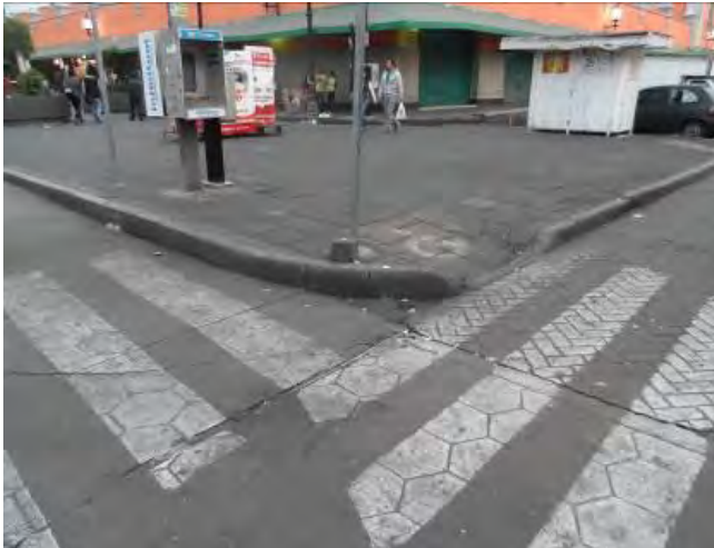
Imagen 167. Fotografía de la calle Vicente Guerrero esquina con la Av. José Ma. Morelos, en la cual se aprecia la existencia de una rampa para personas con discapacidad en la banqueta, esto a pesar de ser esquina y tener acceso en ambos sentidos, centro Histórico de Xochimilco, octubre 2015.
