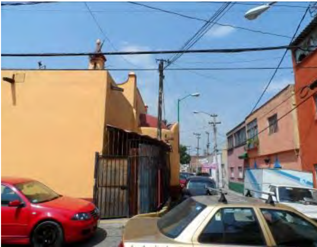
Imagen 197. Fotografía de la fachada sur-oriente de la capilla de San Antonio, se muestran los elementos metálicos que le han añadido a la capilla, así como el desorden urbano existente en su perímetro (líneas de cableado eléctrico y vehículos estacionados), octubre 2015.
