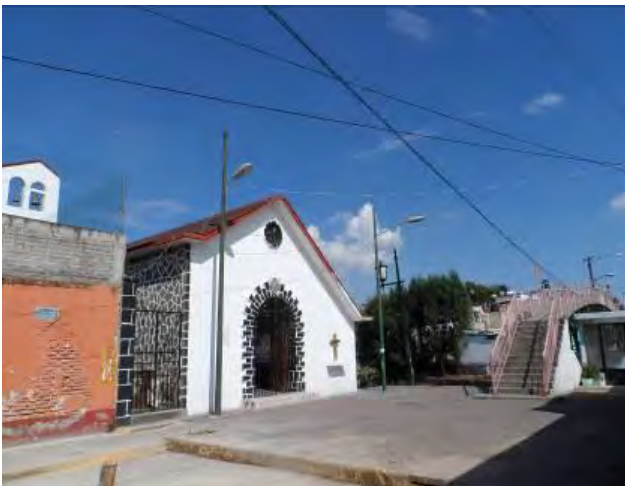
Imagen 222. Fuente: Fotografía de la fachada principal de la capilla de San Diego, se muestran el mobiliario urbano que se existente en el perímetro de la capilla (postes de concreto, puente peatonal y cableado eléctrico aéreo), octubre 2015.
