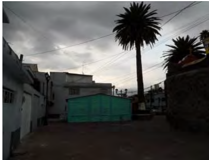
Imagen 259. Fotografía de la fachada sur de la capilla de la Santísima, se muestra la colocación de caseta de lamino pinto a un costado de la capilla, octubre 2015.
