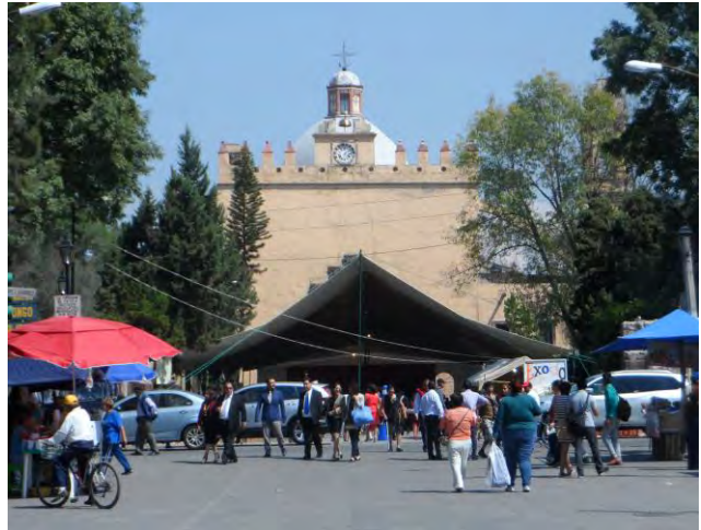
Imagen 304. Fotografía de la fachada principal del Templo y ex convento de San Bernardino de Siena, la cual se observa la espadaña que colapso a consecuencia del sismo del 19 de septiembre de 2017, centro Histórico de Xochimilco, en octubre 2017.
