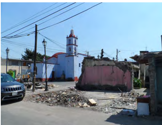
Imagen 293. Fotografía de la fachada Norte de la Capilla de Belem, se observa el espacio que estaba ocupado por una casa la cual colapso debido al sismo del 19 de septiembre, asimismo, se aprecia el estado en el que se encuentra la construcción que se ubica frente a la fachada oriente de la capilla, octubre 2017.
