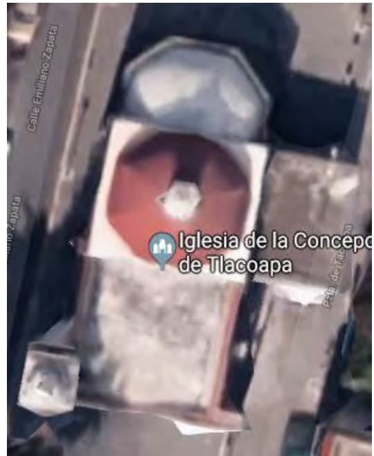
Imagen 60. Imagen aérea de la Cubierta de la Capilla de la Concepción, marzo 2014. Fuente: www.googlemaps .
