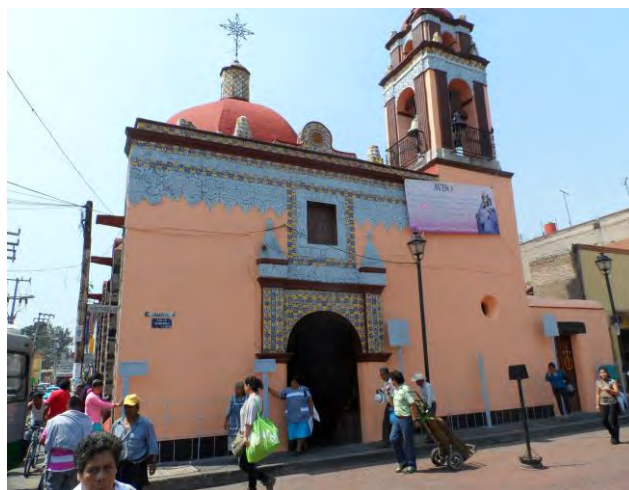
Imagen 253. Fotografía de la fachada principal de la capilla del Rosario, se muestran el tipo de señalamiento y barrera metálica que se ubica frente a la fachada de la capilla y adosada a la misma, octubre 2015.
