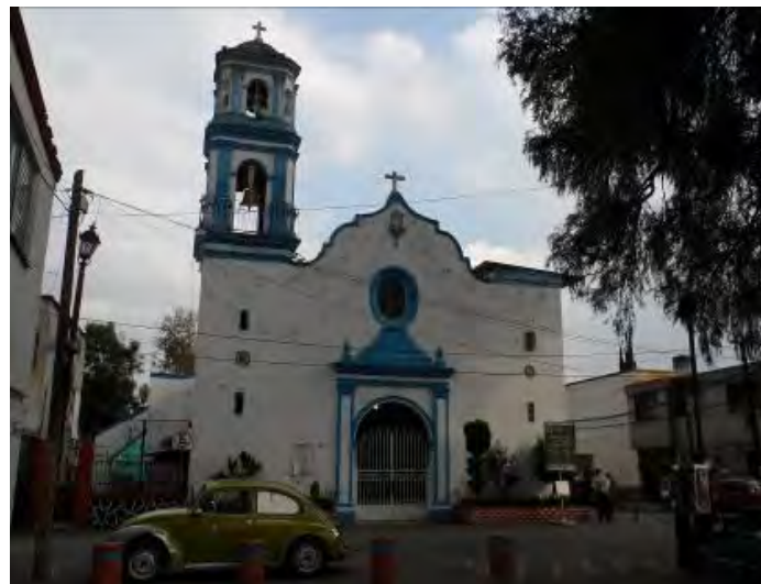
Imagen 203. Fotografía de la fachada Principal de la capilla de La Asunción, se muestran elementos que le han ido añadiendo (jardineras), líneas aéreas de cableado eléctrico existentes, colocación de lámina metálica en la parte superior de la capilla y la utilización de la plaza de la capilla como estacionamiento, octubre 2015.
