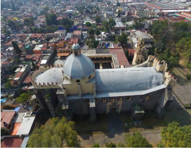
Imagen 333. Imagen aérea de la fachada Norte del Templo y ex convento de San Bernardino de Siena, se puede apreciar el ábside, cúpula y bóveda de cañón corrido los cuales no sufrieron ningún tipo afectación por el sismo del 19 de septiembre, octubre 2017.
