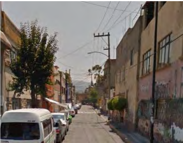
Imagen 173. Fotografía de fachada de una casa con pintura y aplanados dañados, ubicado en la calle Clavel entre ahuehuetes y Josefa Ortiz de Domínguez, centro Histórico de Xochimilco, octubre 2015.
