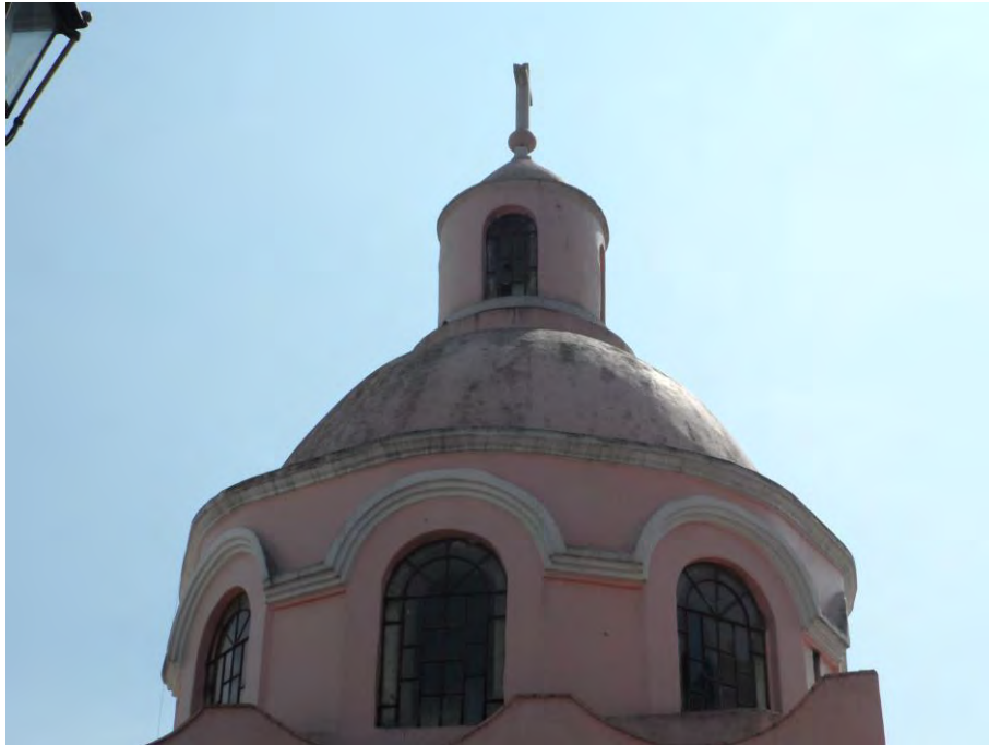
Imagen 102. Imagen del tambor de cúpula y cúpula de la Capilla de San Juan, octubre 2013.
