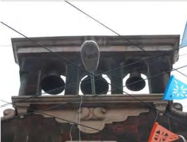
Imagen 240. Fotografía de la fachada principal de la capilla de San Lorenzo, se muestra la existencia de luminaria de alumbrado público adosada a la fachada para iluminar a la misma, octubre 2015.
