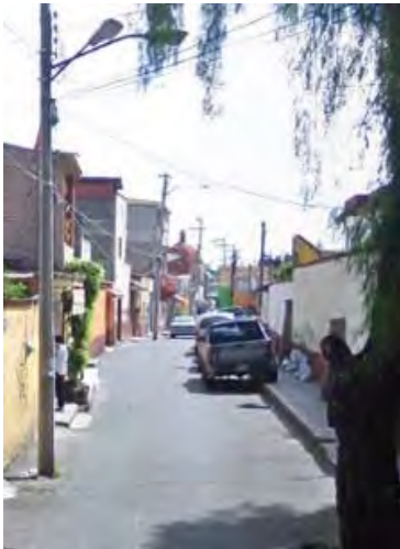
Imagen 164 Fotografía de la calle Francisco I. Madero esquina con Pedro Ramírez Del Castillo, en la cual se observa que la calle solo cuenta con banqueta en una acera, centro Histórico de Xochimilco, octubre 2015.
