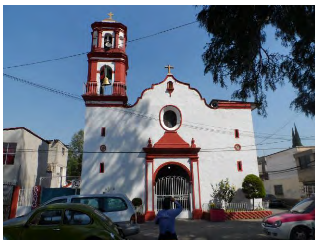
Imagen 286. Fotografía de la fachada de la Capilla de la Asunción, se observa que tiene poco tiempo que fue pintada la capilla, octubre 2017.
