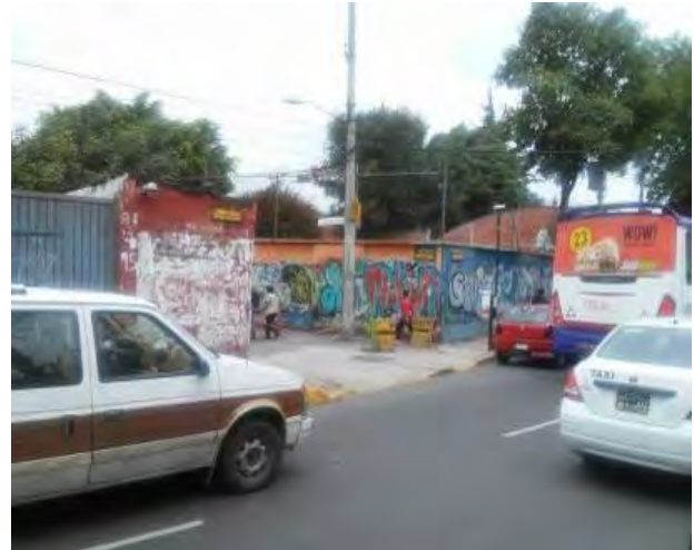
Imagen 172. Fotografía de barda de un inmueble con grafiti, ubicado en la calle Selva esquina con Av. 16 de septiembre, lo cual provoca un deterioro a la imagen urbana, centro de Xochimilco, octubre 2015.
