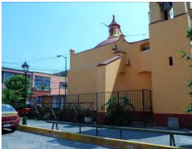
Imagen 198. Fotografía de la fachada norte de la capilla de San Antonio, se muestra estructura metálica añadida y adosada a la capilla, octubre 2015.
