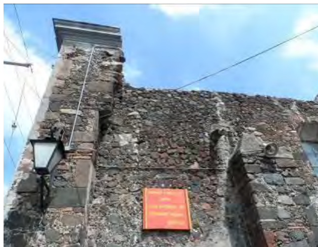
Imagen 217. Fotografía de la fachada sur de la capilla Santa Crucita, en la cual se muestra canalización de instalación eléctrica y luminarias empotradas en muros, esto a pesar de que el INAH prohíbe este tipo de instalaciones en los Monumentos Históricos, octubre 2015.
