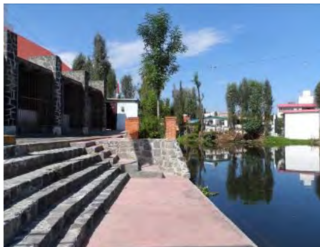
Imagen 224. Fotografía de la fachada oriente de la capilla de San Diego, se muestra el entorno ecológico en el cual se ubica la capilla, octubre 2015.
