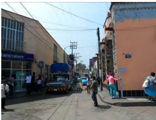
Imagen 252. Fotografía de la fachada sur de la capilla del Rosario, se muestra la mala imagen urbana que existe en la zona, así como la ubicación de postes de madera con líneas de telefonía, octubre 2015.
