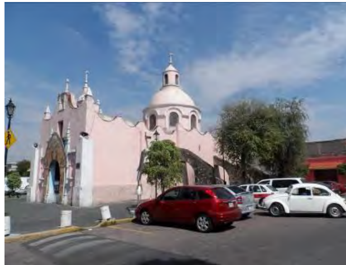
Imagen 237. Fotografía de la fachada sur de la capilla de San Juan, se muestran vehículos estacionados en el perímetro de la capilla aun cuando por reglamentación está restringido, octubre 2015.
