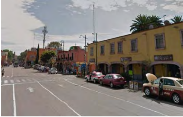
Imagen 184. Fotografía en la cual se muestra la buena imagen urbana de la Av. Guadalupe I. Ramírez, libre de cableado aéreo, centro de Xochimilco, octubre 2015.
