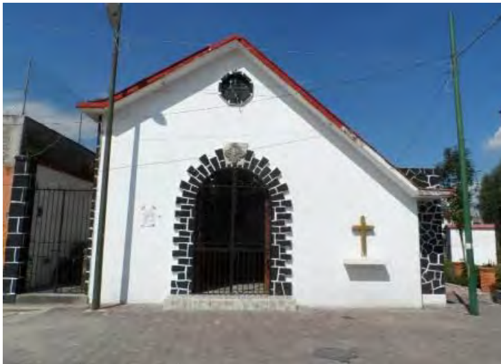
Imagen 78. Fachada de la Capilla de San Diego, noviembre 2013.
