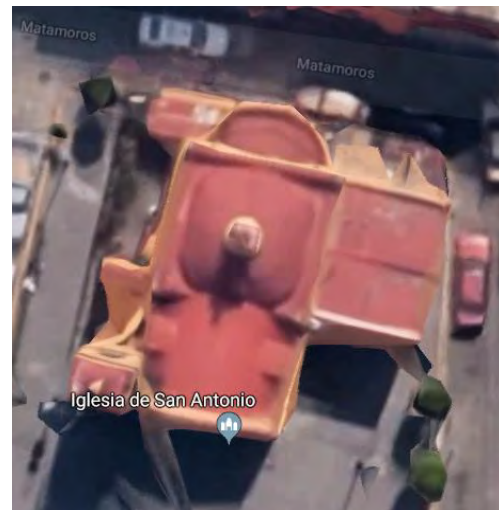
Imagen 42. Imagen aérea de la Cubierta de la Capilla de San Antonio, marzo 2014. Fuente: www.googlemaps .
