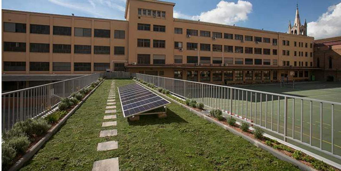
Figure 39. Barcelona Green Roof- Salesinas de Sarria (source:construible.es)
