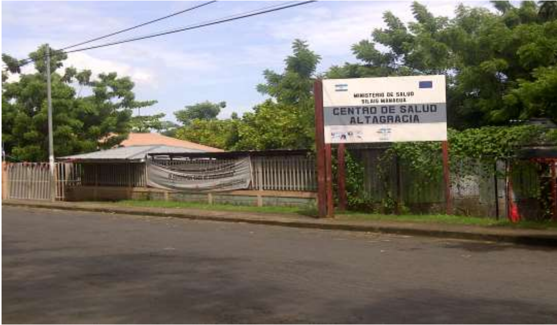
Instalaciones del C/S Altagracia. Fuente las autoras.
