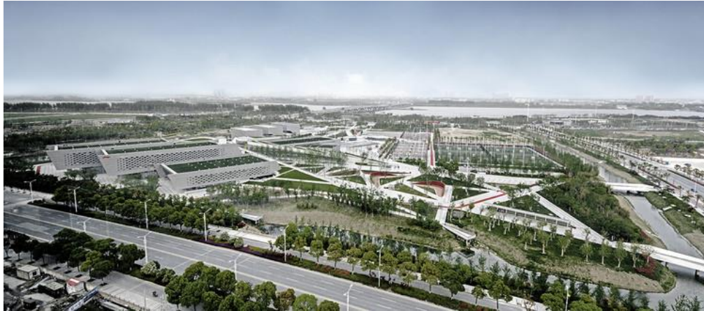
Figura 6. Parque deportivo Yangzhou Li Ning.
