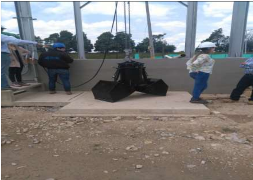
Ilustración 15. Pozo de gruesos y cuchara bivalva
