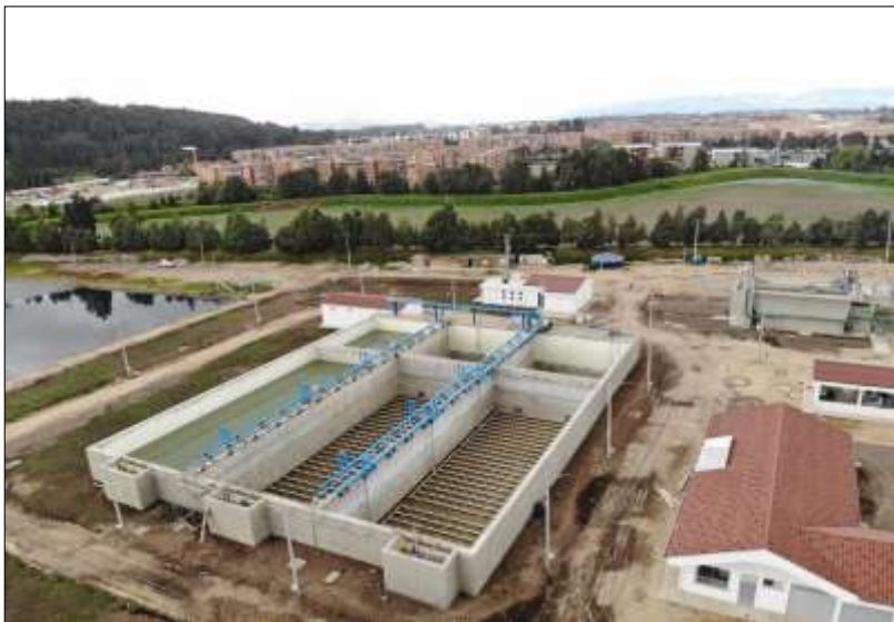
Ilustración 26. Reactores Biológicos
