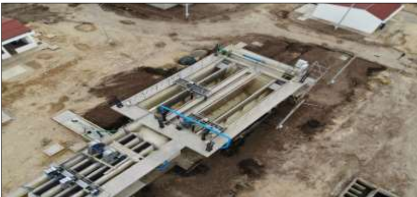
Ilustración 17. Canales de desbaste
