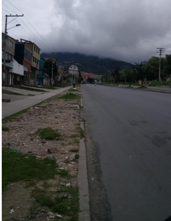
Fotografía 3. Intersección aforada, diagonal 82 sur.
