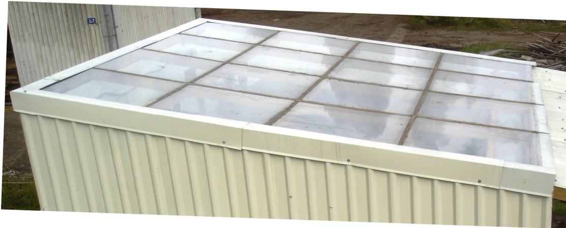
VISTA SUPERIOR DEL TECHO INSTALADO
