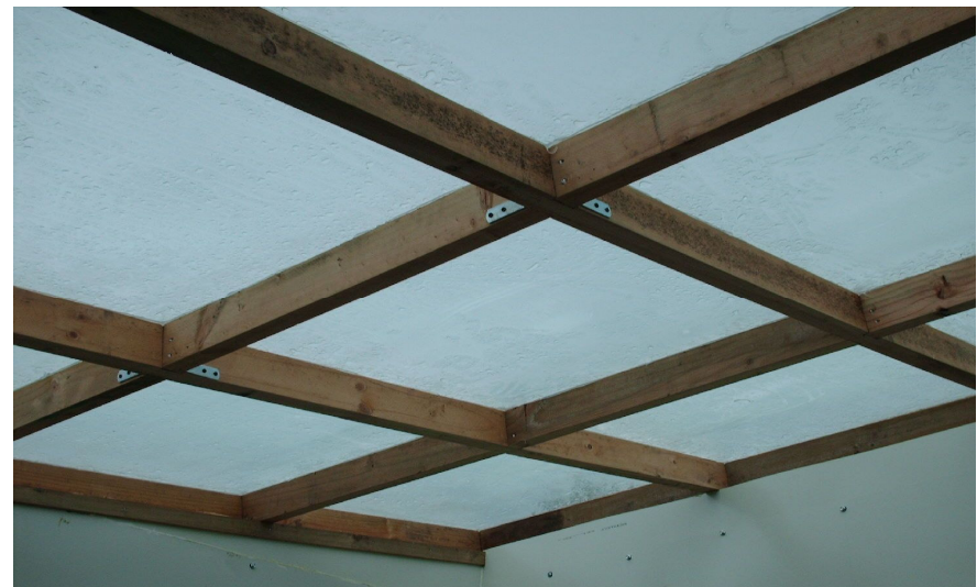
VISTA INFERIOR DEL TECHO INSTALADO EL USO DE ESCUADRAS DA MEJOR SOPORTE A LOS CUADROS QUE SOPORTAN EL VIDRIO
