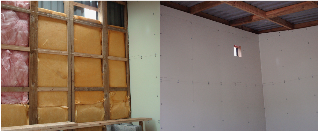
Figura 4. A la izquierda se observa el uso de la fibra de vidrio como aislante entre forros. A la derecha se observa la misma pared interna ya forrada internamente.
