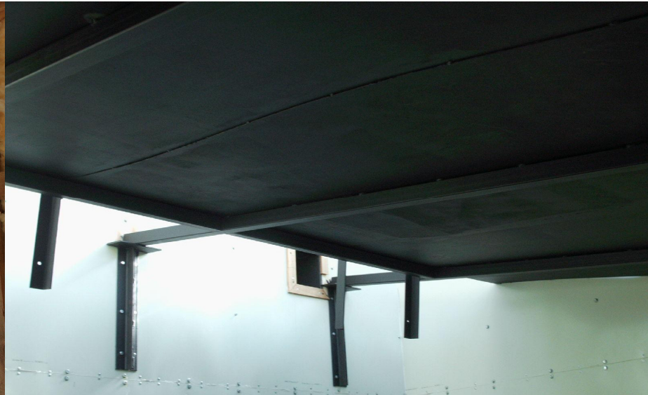
DETALLE DE SOPORTES DEL COLECTOR Y COLECTOR
