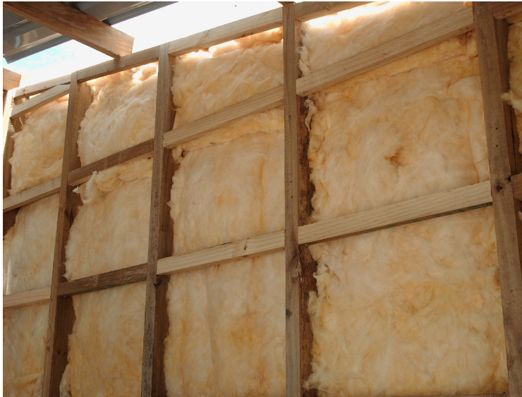
INSTALACION DE FIBRA DE VIDRIO
