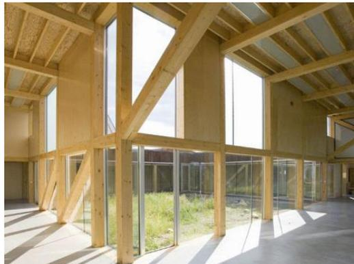
**Figura 1.4 Sistema de entramado pesado**
