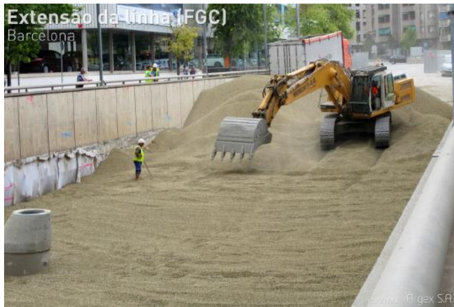
Figura 6: Proyecto Túnel Sabadell Barcelona, España
