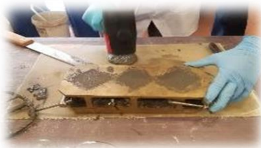
c). Apisonamiento con chipote para garantizar compactación
