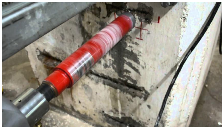
Figura 4 Ensayo de extracción de núcleos
