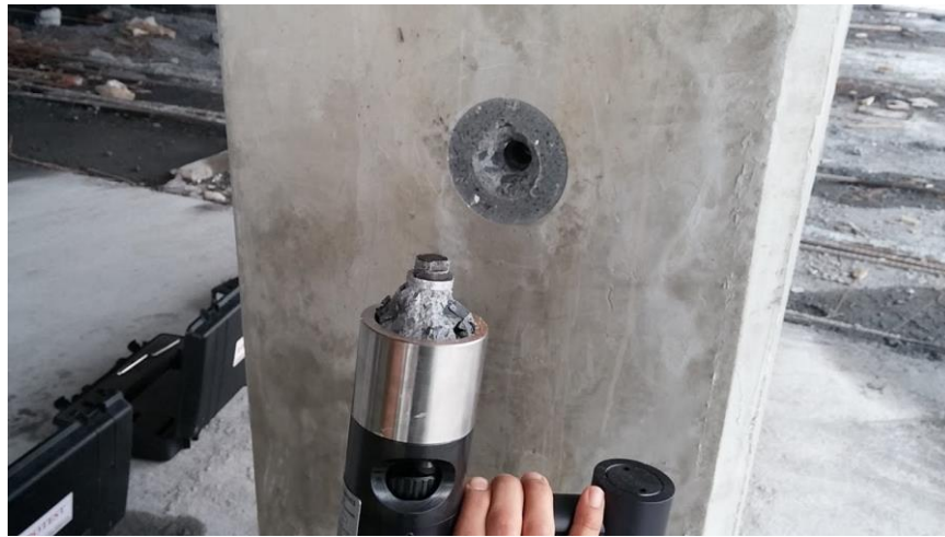
Figura 6. Prueba de la extracción o Pull – Out
