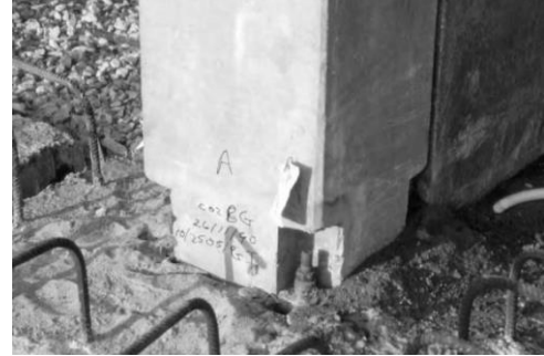
Figura 21. Conexión con placa base con cajones esquineros. Obtenido de (Elliott, 2002)
