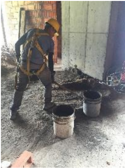
Ilustración 24. Elaboración del mortero
