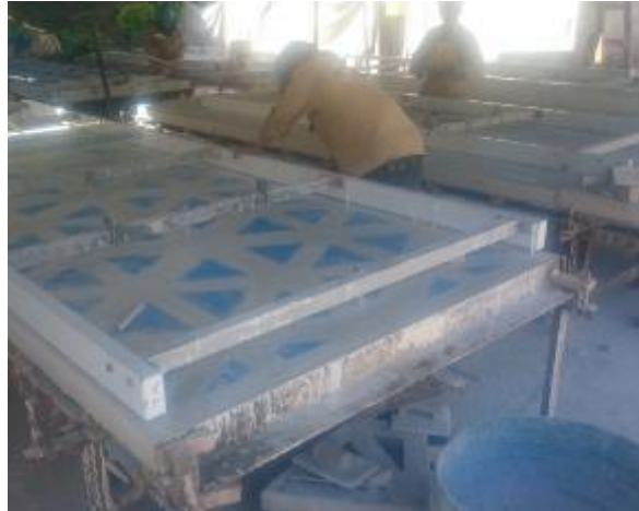
Ilustración 9. Puesto de trabajo fabricación de paneles
