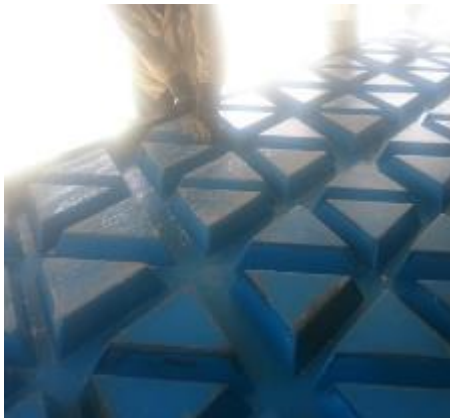
Ilustración 10. Vaciado mortero inicial
