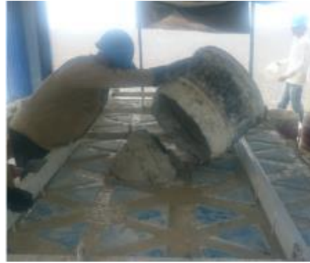
Ilustración 13. Vaciado con mortero N.3
