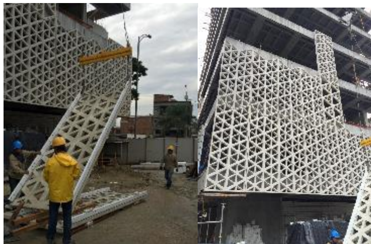
Ilustración 17. Izamiento del panel
