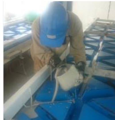
Ilustración 11. Aplicación desmoldante
