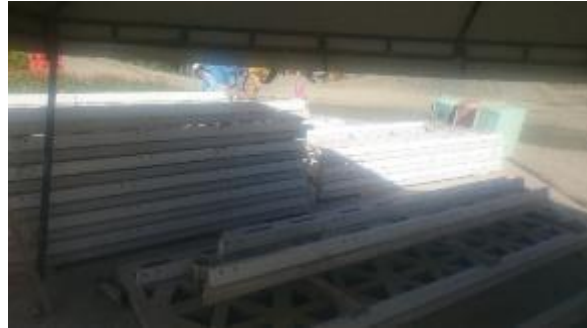
Ilustración 15. Módulos desencofrados y almacenados
