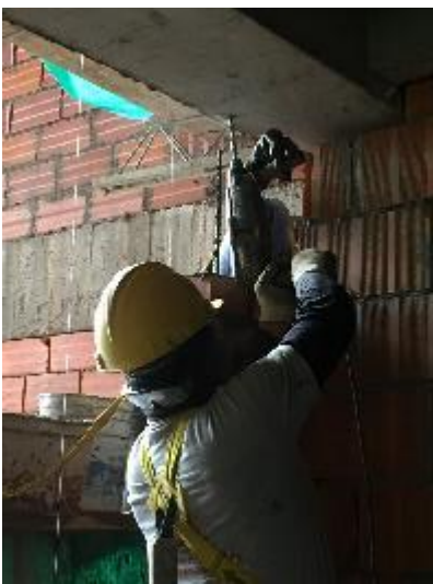
Ilustración 27. Anclaje del muro
