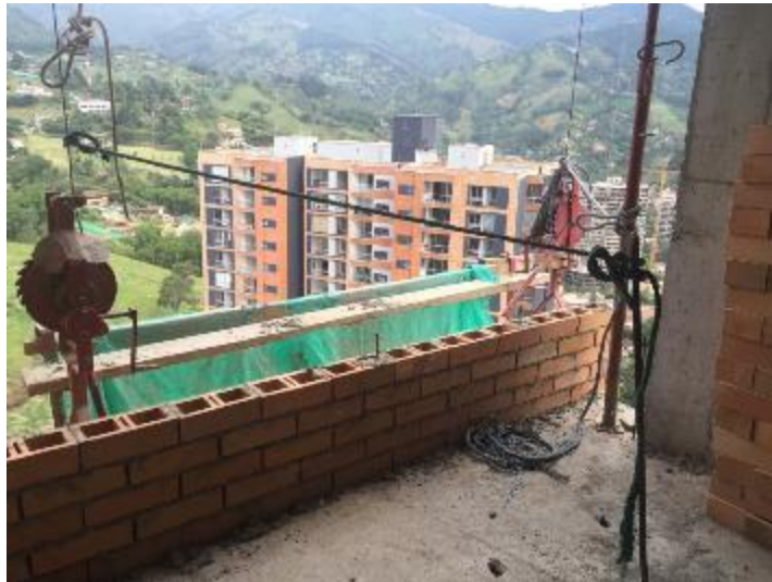
Ilustración 23. Andamios para la construcción de fachada
