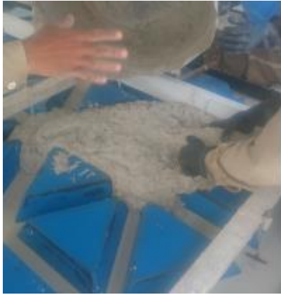
Ilustración 12. Vaciado Mortero con fibra de vidrio
