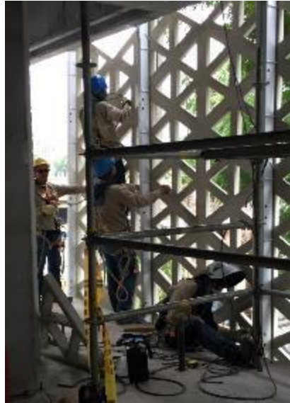
Ilustración 20. Anclaje y colocación de capa de pintura anticorrosiva
