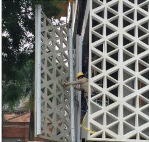
Ilustración 18. Acercamiento y amarre del panel GRC
