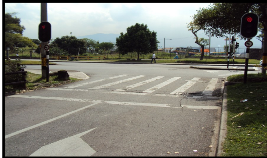
Foto 6. Acceso occidental. El observador está parado en el acceso occidental mirando hacia el oriente. (Fuente: elaboración propia).
