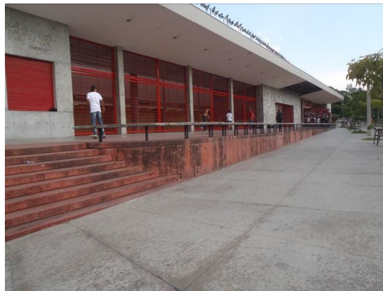
Figura 41. Rampa acceso norte
