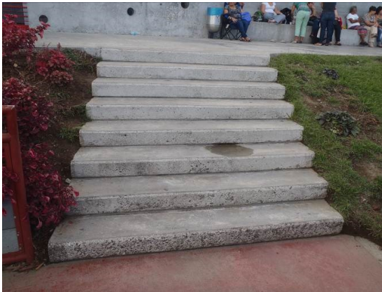
Figura 39. Escaleras acceso pista de patinaje
