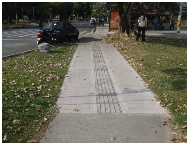
Figura 33. Continuación andén (a)
