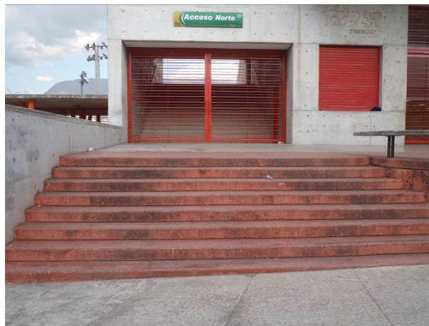
Figura 37. Escaleras acceso norte
