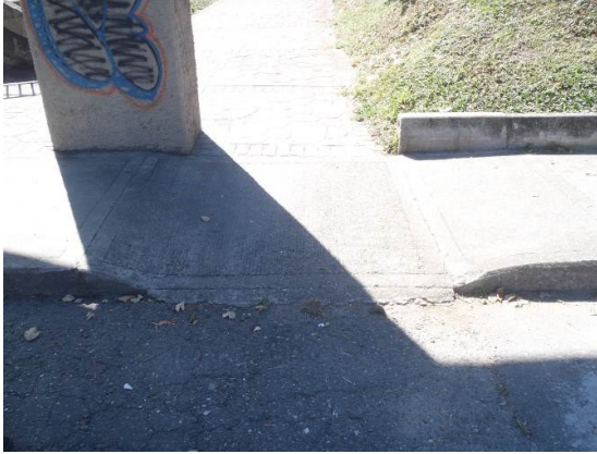
Figura 67. Vado Acceso Parque
