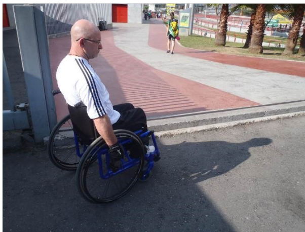
Figura 46. Desnivel parqueadero – acceso unidad deportiva
