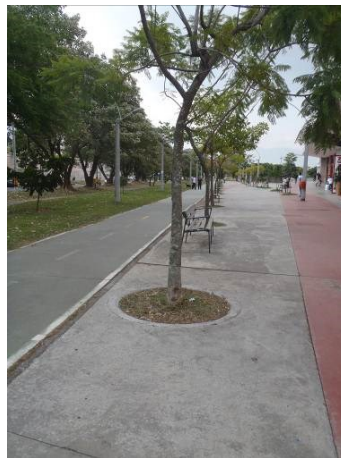
Figura 35. Alcorques sin rejillas
