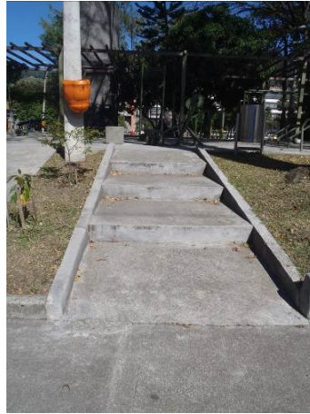
Figura 77. Rampa escalonada carrera 53
