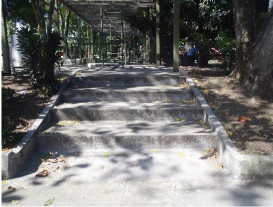
Figura 73. Escaleras calle 16 A
