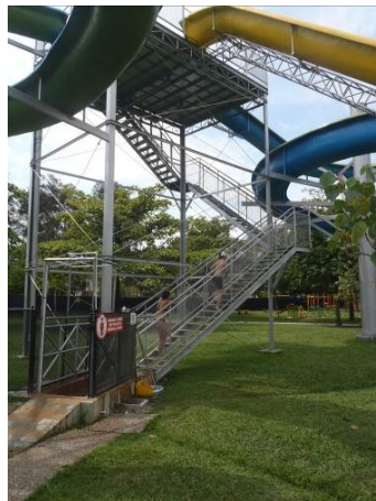
Figura 92. Escaleras piscina de toboganes
