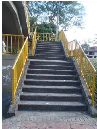
Figura 72. Escaleras puente peatonal
