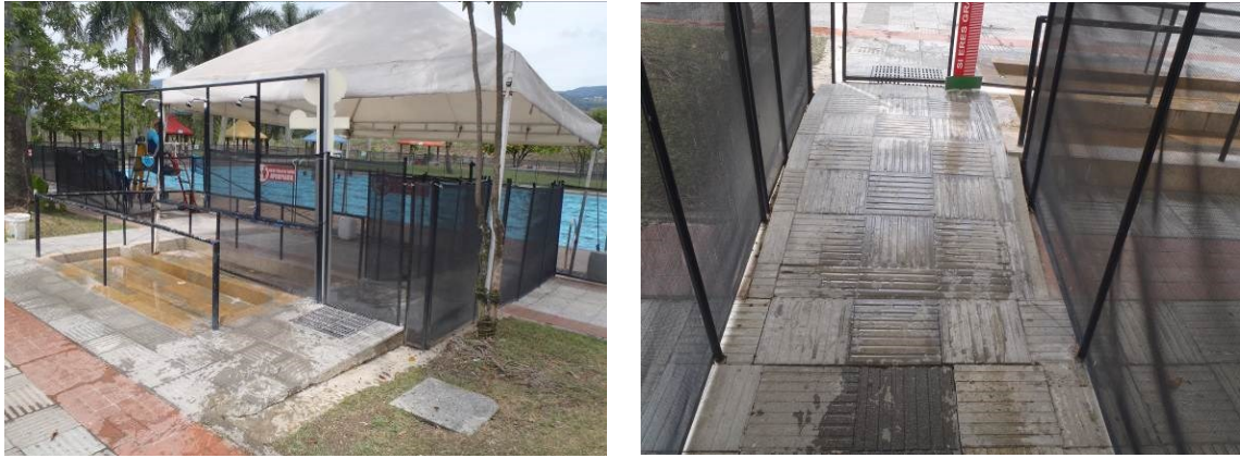
Figura 97. Rampa acceso piscina semiolímpica
