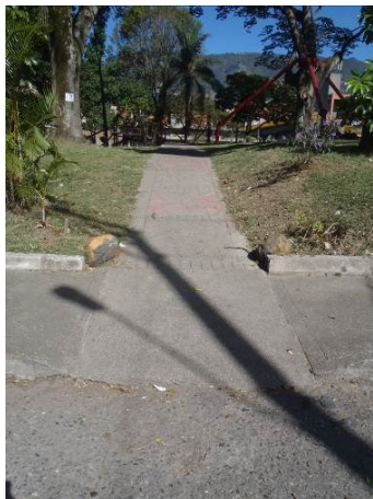
Figura 76. Rampa acceso carrera 53
