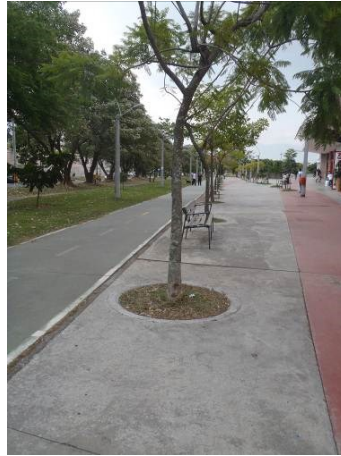
Figura 48. Alcorques sin rejillas
