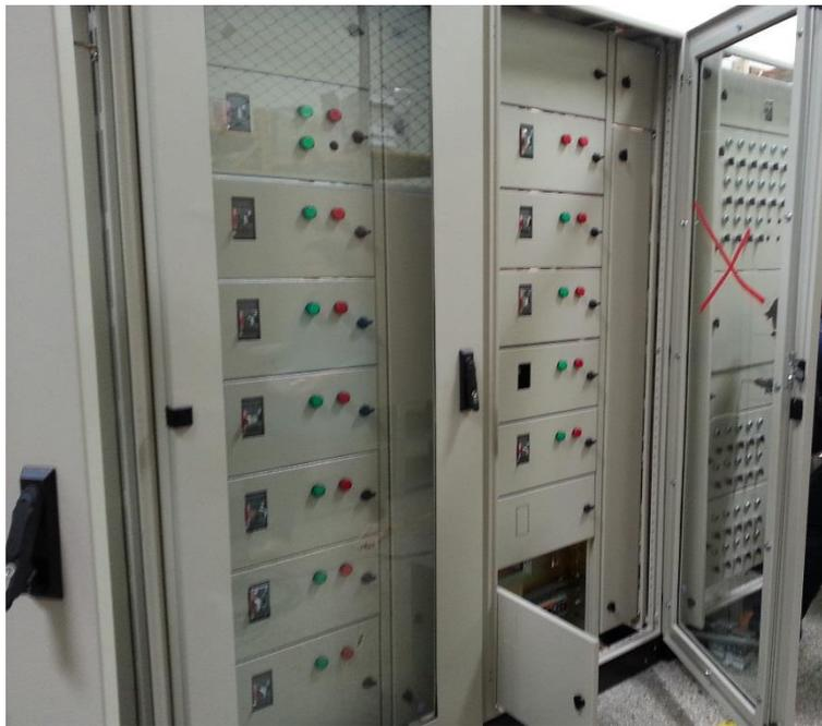
**Figura 17. Fabricación tablero MCC, vista frontal (Gutiérrez & Lopera, 2013).**
