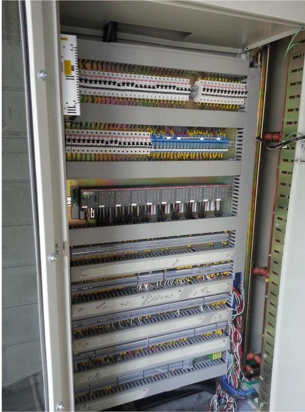
**Figura 25. Conexión de módulo de control MCC (Gutiérrez & Lopera, 2013)**
