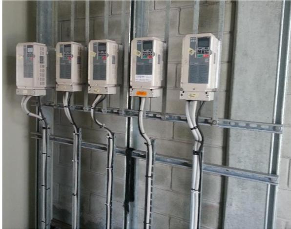
**Figura 19. Montaje rack de Variadores en sala eléctrica (Gutiérrez & Lopera, 2013).**
