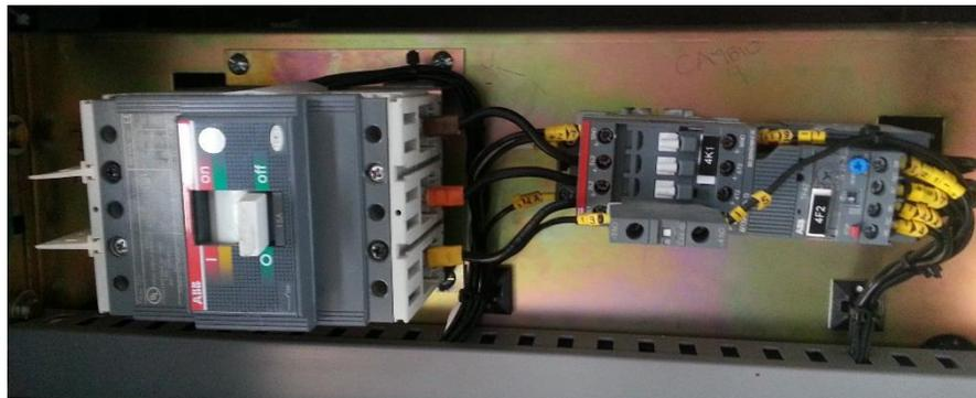
**Figura 24. Disposición de conexión de breaker, contacto y relé térmico (Gutiérrez & Lopera, 2013)**
