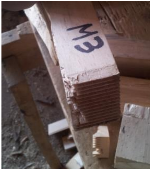
Ilustración 22 Falla en la unión dentada
