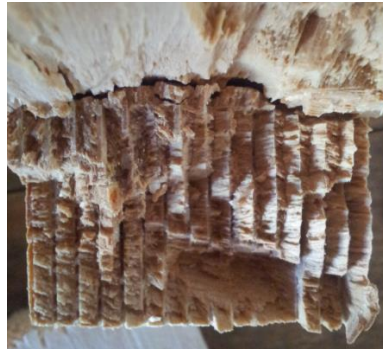
Ilustración 20 Falla de la madera en el finger joints
