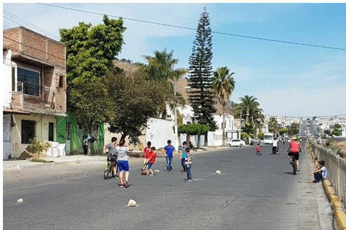
Imagen 93: Sitios con necesidad de rehabilitación.
