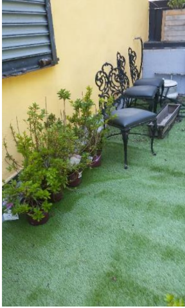
ILUSTRACIÓN II.6—15. TERRAZA Y ROOF PROTECTION TERMINADOS 1
