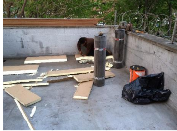
ILUSTRACIÓN II.6—14. TRABAJOS TERRAZA Y ROOF PROTECTION
