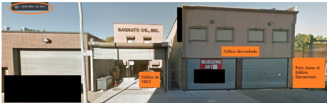
ILUSTRACIÓN II.6—52. VISTA DEL EDIFICIO EN OCTUBRE DEL 2013
