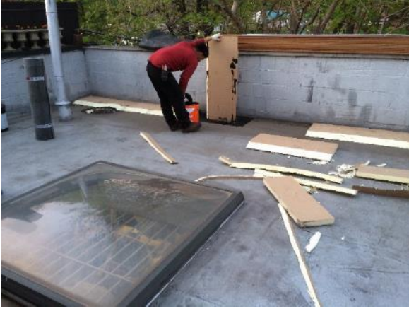
ILUSTRACIÓN II.6—13. TRABAJOS TERRAZA Y ROOF PROTECTION
