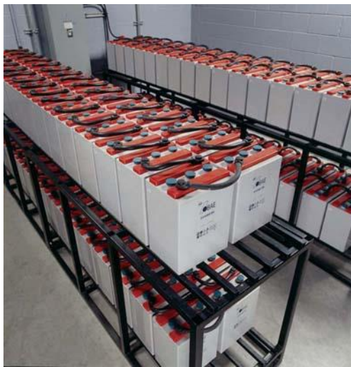
Figura 2.14. Sistema de almacenamiento mediante banco de baterías (23)
