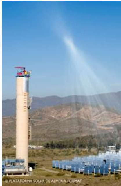
Figura 2.11. Sistema receptor central de torre en la PSA (18)
