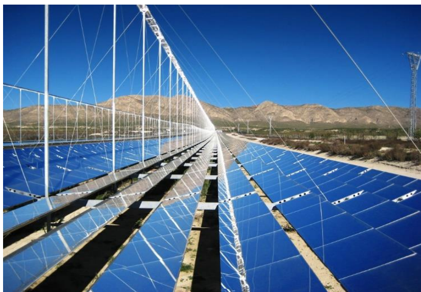
Figura 2.10. Concentradores lineales tipo Fresnel en la planta termosolar Puerto Errado 2, Murcia (19)
