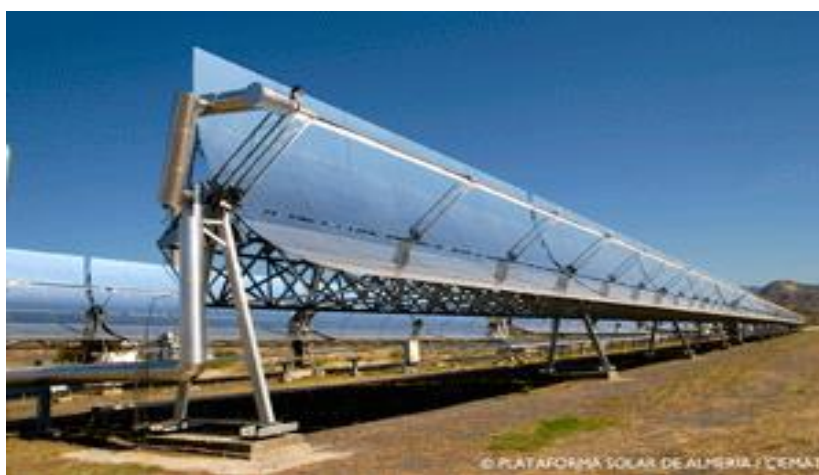
Figura 2.9. Captadores cilindroparabólicos en la PSA (18)
