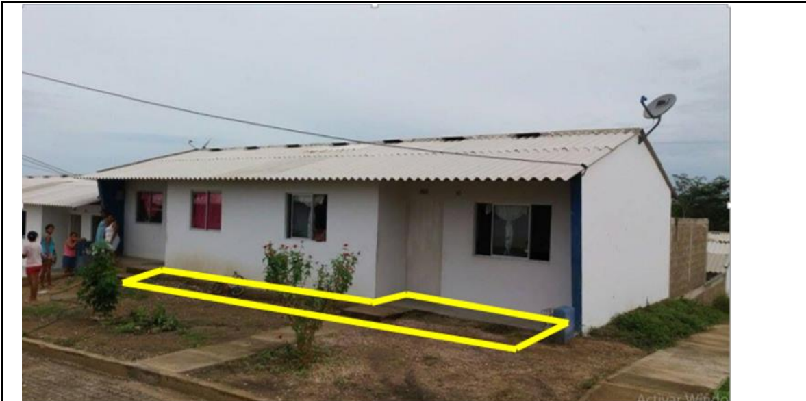
Fuente: fotografías tomadas por autor
