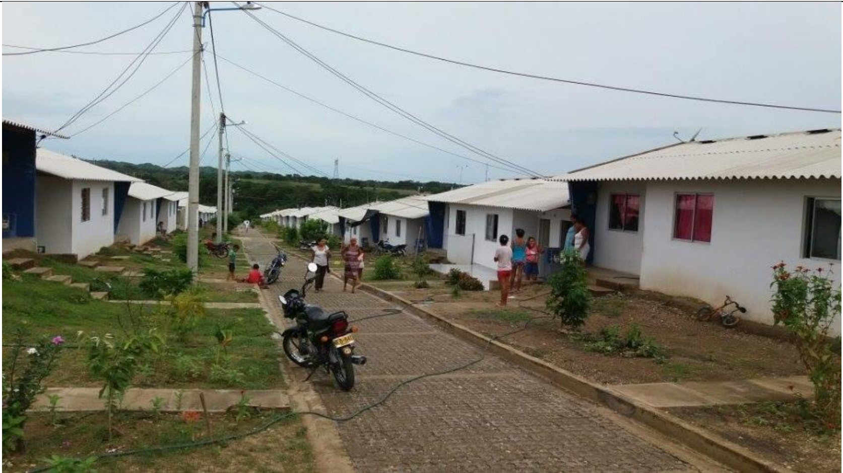
Fuente: fotografías tomadas por autor
