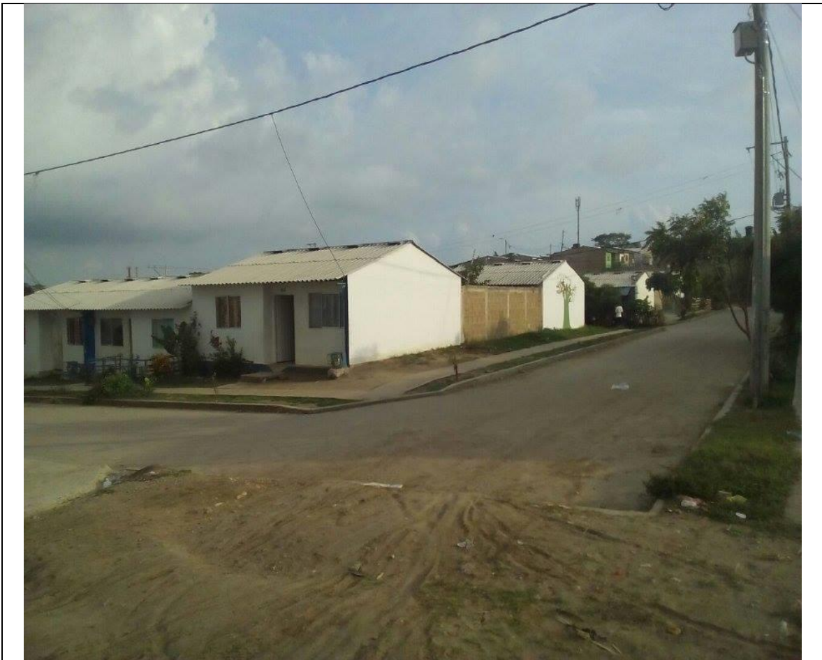
FIGURA 15 VIVIENDA SOCIAL DEL BARRIO TIERRA GRATA II ETAPA 1.
