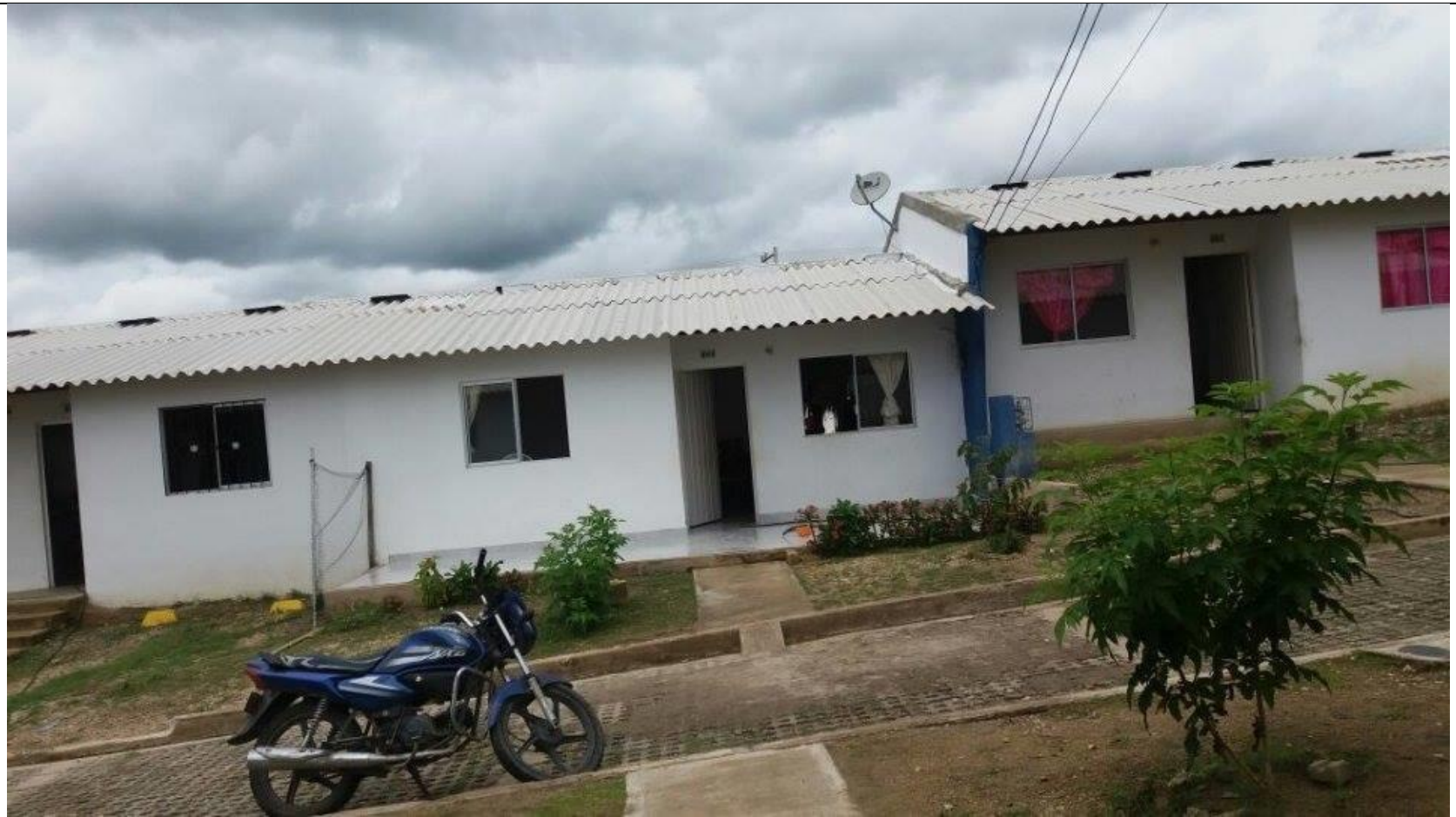
Fuente: fotografías tomadas por autor
