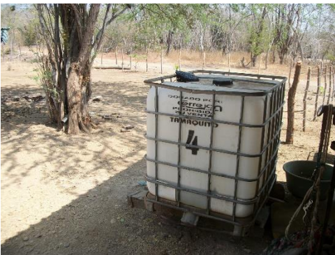
Tanque de 1000 lts. para abastecimiento de agua en carro tanque
