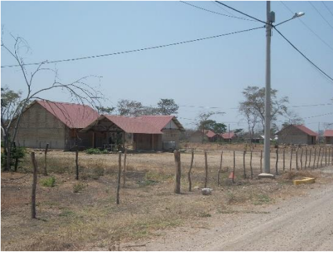
Vivienda unifamiliar en Tamaquito II
