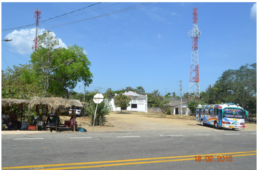
Arriba: Imagen No.4 - Vista de la carretera de interconexión entre la RN-Ruta 90 (La Cordialidad) y la RN-Ruta 90-A (Vía al Mar), en estado de pavimentación reciente mediante la Gobernación de Bolívar.
