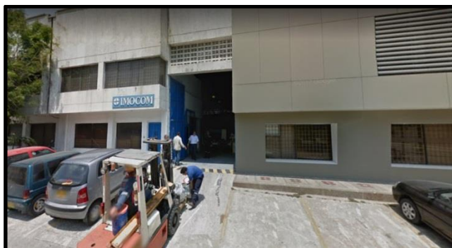
Ilustración 9. Instalaciones IMOCOM S.A.S.
