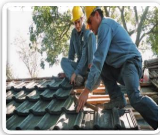
Figura 15. Instalación tejas de Caucho.
