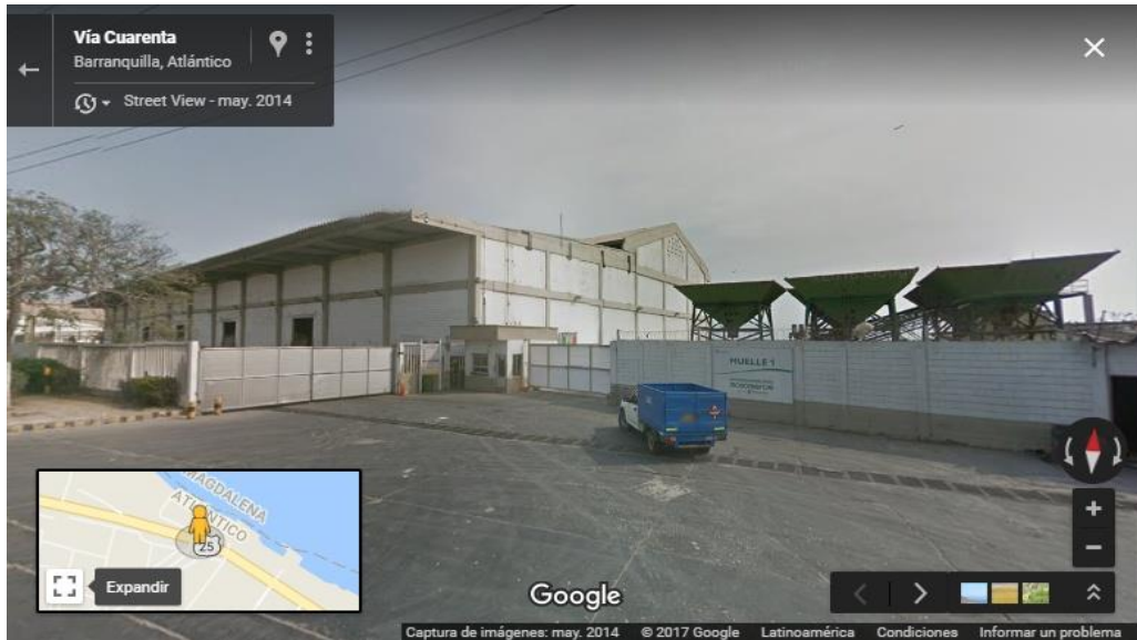
Figura No. 8. Portería Muelle y Bocatoma
