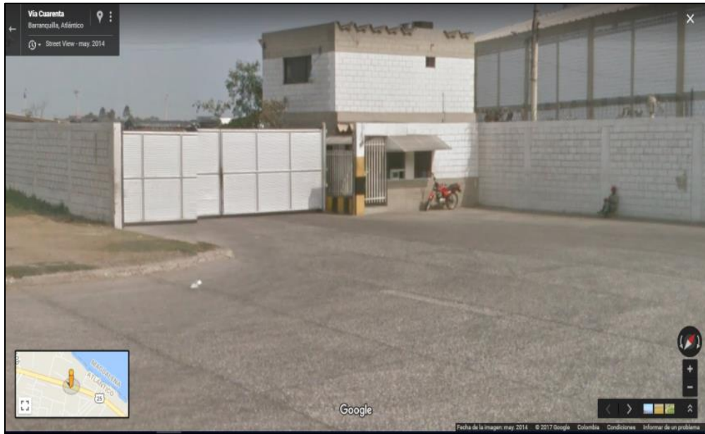
Figura No. 7. Portería de Camiones
