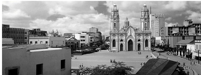
Imagen 18. Iglesia y plaza de San Nicolás después de intervención. Año 2012
