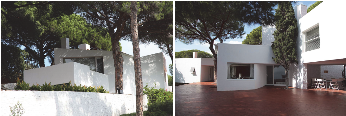
Figura 31. Casa Ugalde en Caldes d'Estrac. Fuente: https://www.casaugalde.com/
