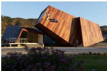
Figura 3. Edificio Smart Grid.
