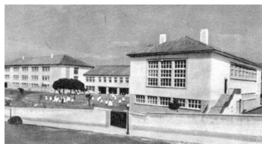
Fig. 17 – Escola Industrial Josefa de Óbidos, inaugurada em 1952, cuja formalização remonta a 1947. O projeto do edifício foi elaborado pelos Serviços Técnicos da Junta de Construções para o Ensino Técnico e Liceal (grupo trabalho do arquiteto José Costa Silva).
