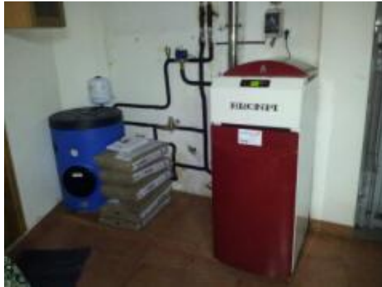
Figura 13 – Instalação sistema aquecimento central com caldeira de pellets ( http://www.fundicalor.com/biobronpi1.htm )
