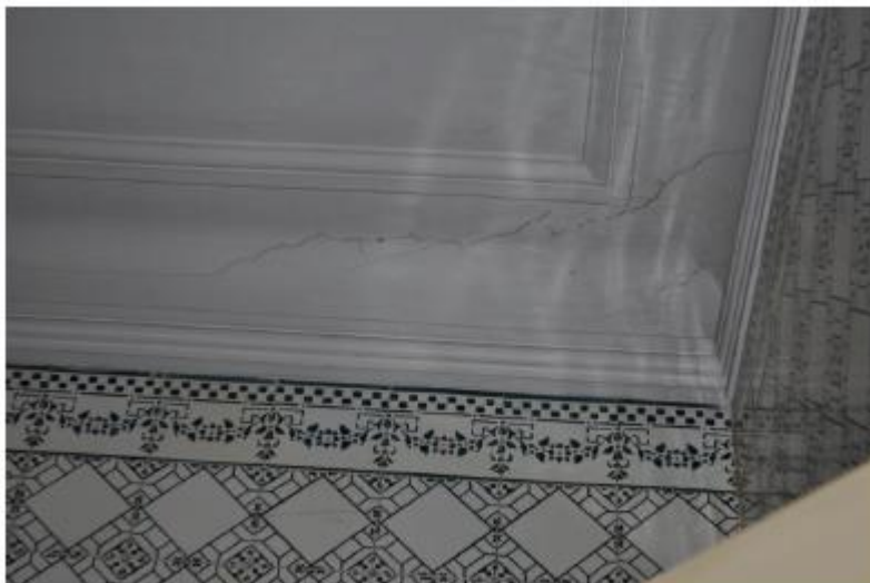
Figura 53 - Exemplo de revestimento cerâmico aplicado em paredes interiores (InovaDomus Anomalias, 2003)
