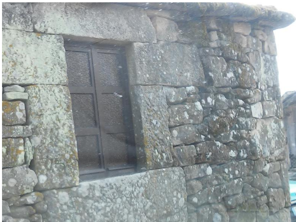
Figura 25 - Exemplo de parede de pedra, com remate em janela
