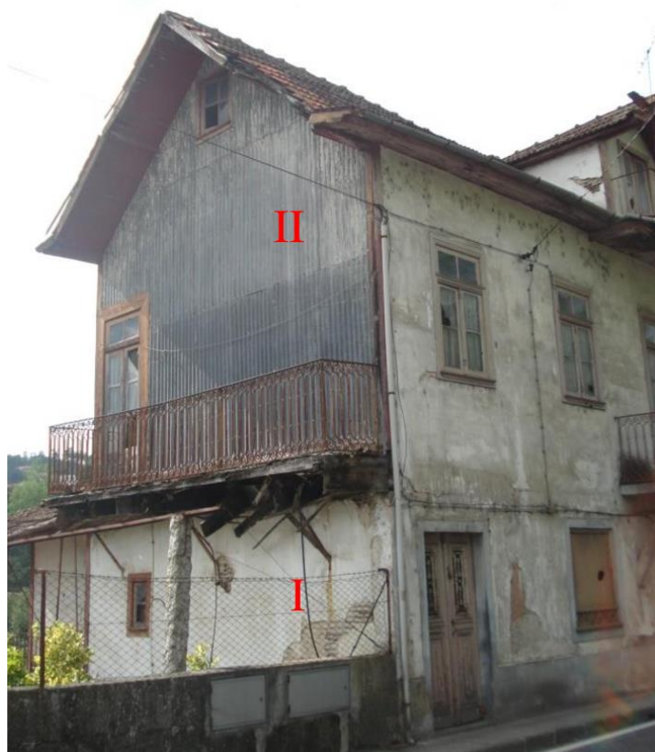
Figura 12 - Moradia com paredes em tabique
