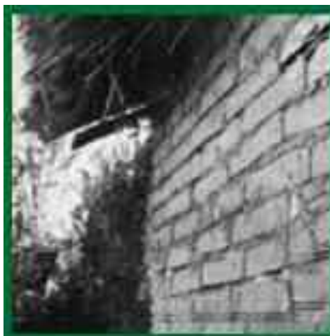
Figura 9 - Parede em adobe
