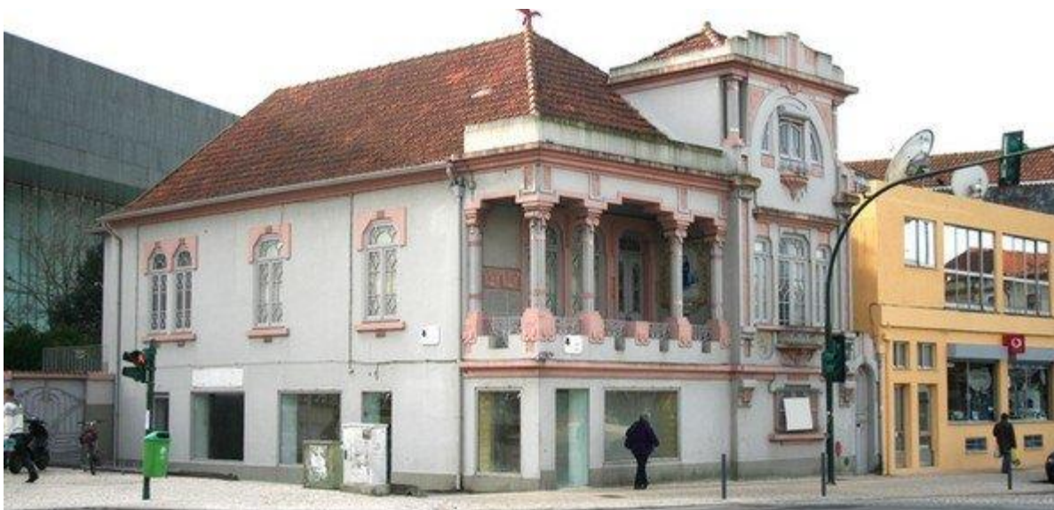
Figura 50 - Apresentação de telhado da Casa InovaDomus
