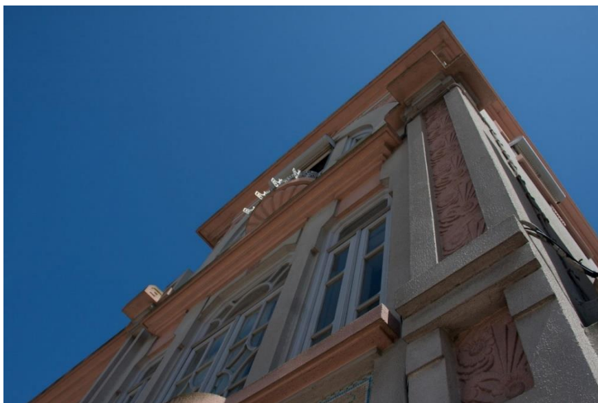
Figura 49 - Pormenor de revestimentos exteriores de paredes
