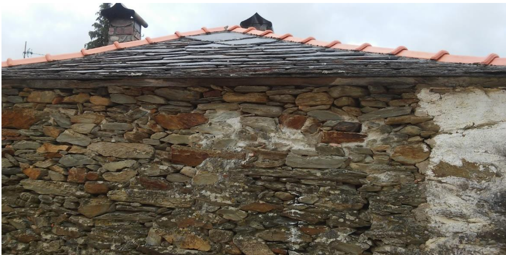
Figura 24 - Exemplo de parede de pedra
