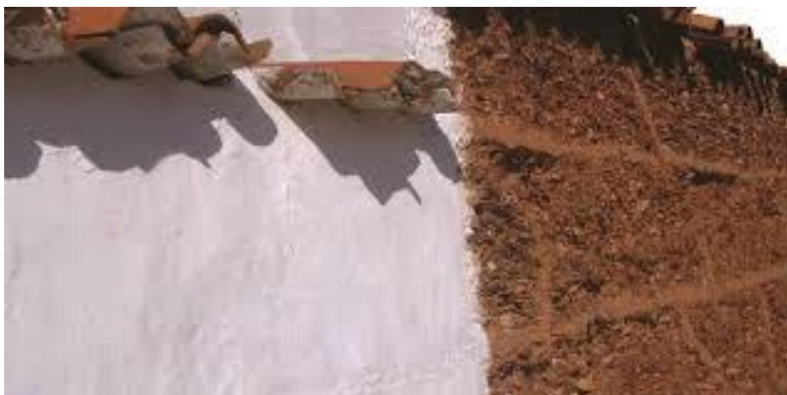
Figura 7 - Pormenor de parede em taipa
