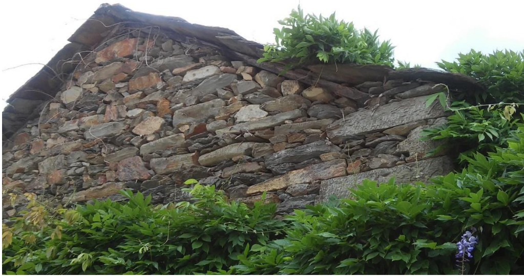
Figura 23 - Exemplo de parede de pedra
