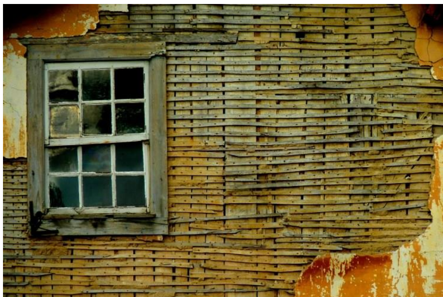
Figura 13 - Pormenor de parede de tabique
