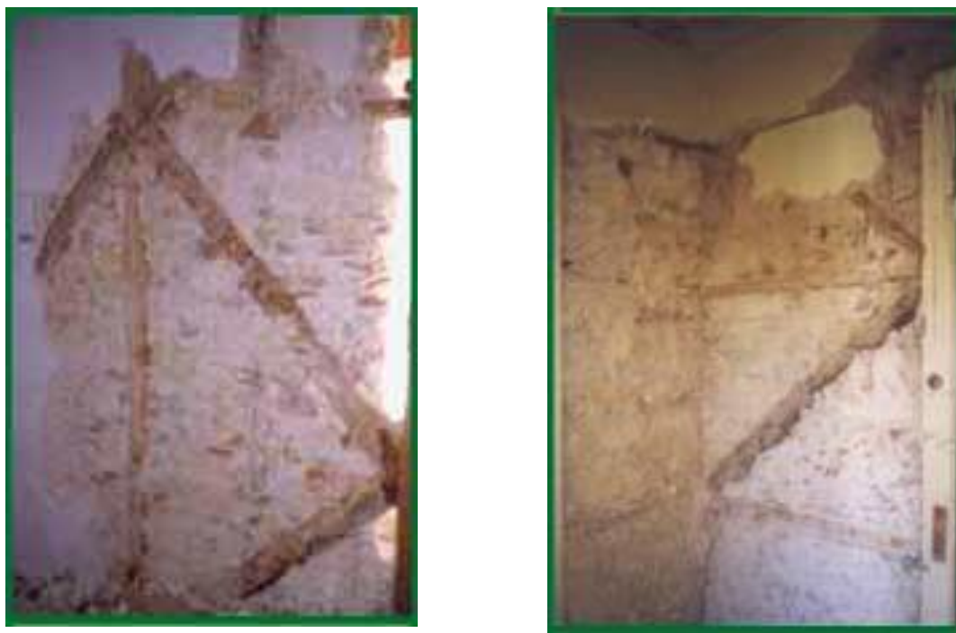
Figura 16 - Pormenores de parede gaiola ( http://paulojones.com/tecnicas/tecnicas.htm )
