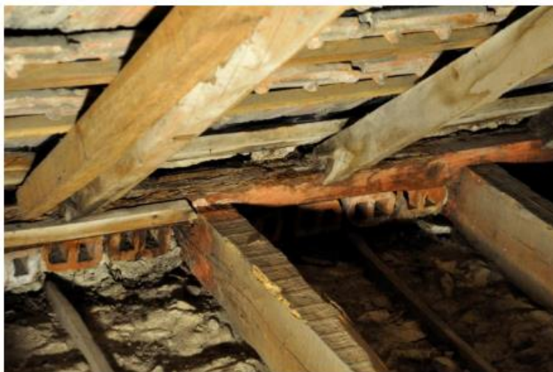
Figura 37 - Degradação do frechal (InovaDomus Anomalias, 2003)
