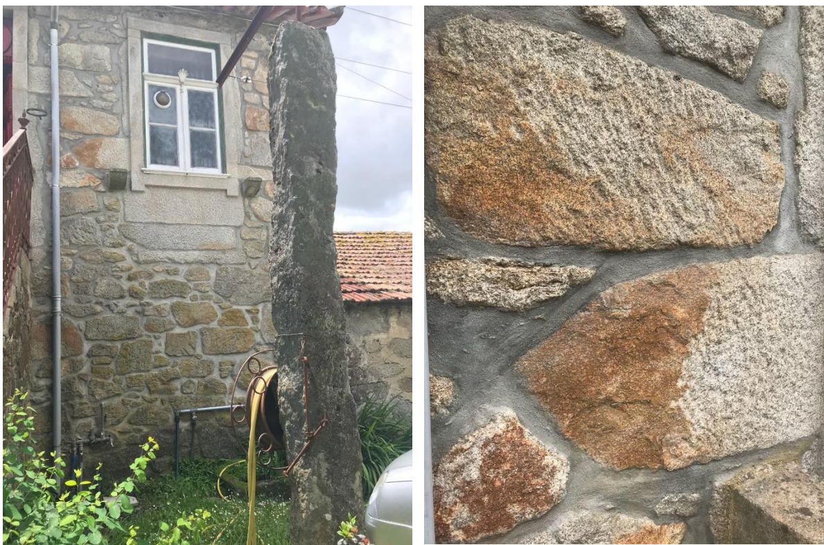
Figura 3 - Exemplos de paredes tradicionais em pedra
