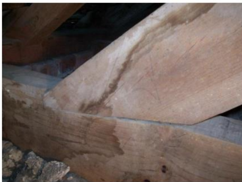
Figura 33 - Ligação asnas com vigas (InovaDomus Anomalias, 2003)
