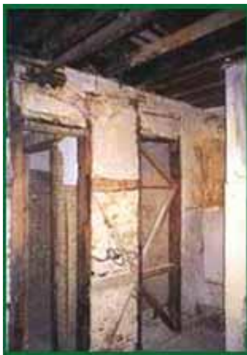
Figura 15 - Exemplo de parede em gaiola ( http://paulojones.com/tecnicas/tecnicas.htm )
