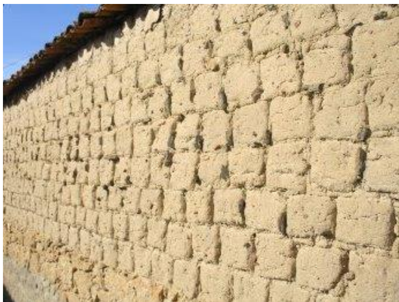
Figura 10 - Exemplo de parede em adobe ( http://paulojones.com/tecnicas/tecnicas.htm )
