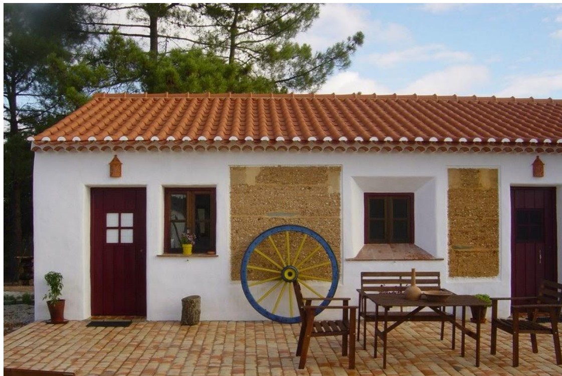
Figura 6 - Exemplo de construção em taipa
