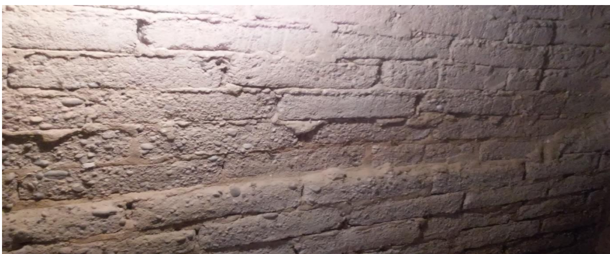
Figura 4 - Exemplo de parede tradicional em adobe
