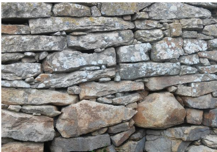
Figura 22 - Exemplo de parede de pedra
