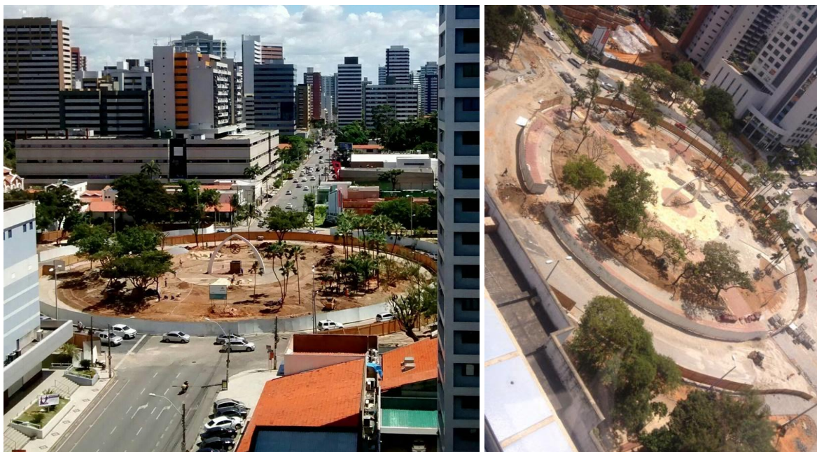
Figuras 193 e 194: Praça Portugal durante obras de remodelação. Fonte: Autor desconhecido, 2016
