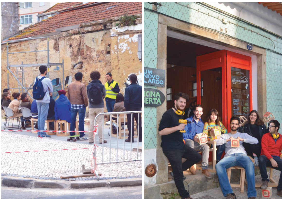
Figura 243 Preparação para o início das obras. Fonte: Actors of Urban Change, 2016
