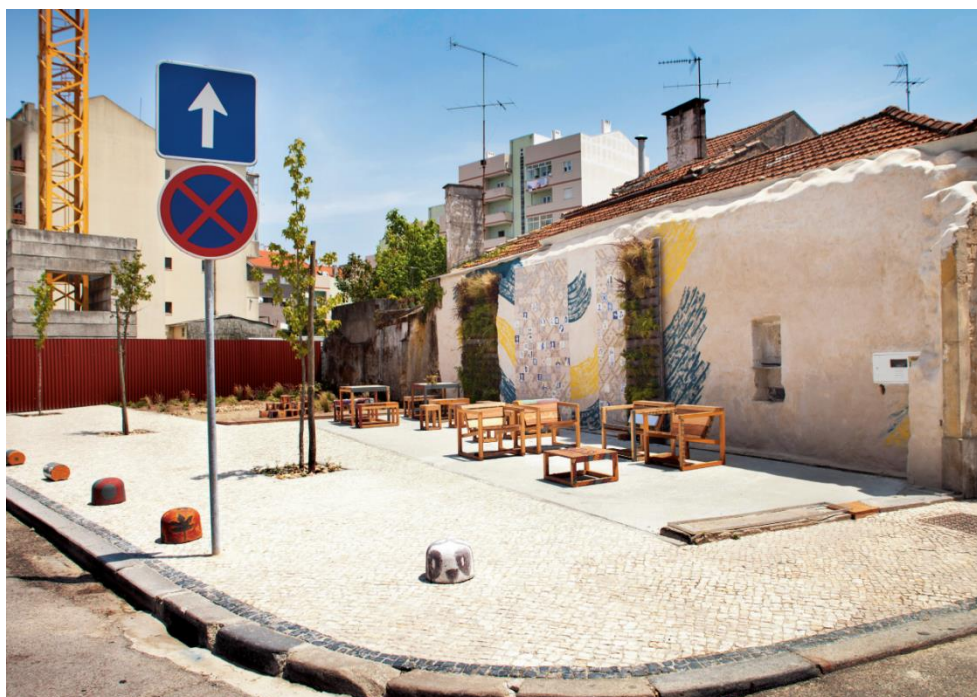
Figura 237: Largo de São Sebastião após término das obras. Fonte: Actors of Urban Change, 2016
