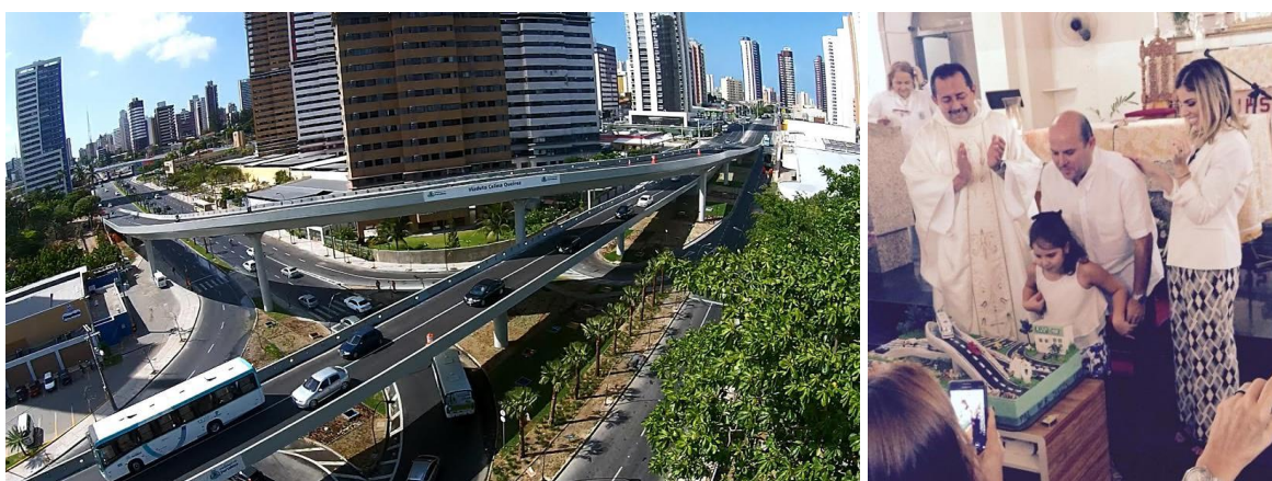
Figura 107: Imagem dos viadutos do Cocó concluídos. Foto: PMF, 2015
