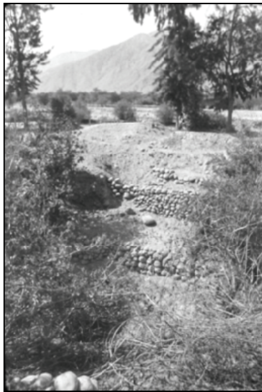
Figura 4. Cantayoc, Nasca. Una de las entradas que bajan en espiral al acueducto subterráneo para limpiarlo periódicamente; las paredes de piedra ( pirca ) evitan el desmoronamiento del terreno arenoso. Al fondo, los cerros de Aja. Foto MG 1977.
