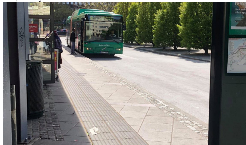
Bild 3. Bristande samspel mellan byggd miljö och fordon. Funktionen uteblir när bussen inte stannar vid hållplatsstolpe och kupolplattor.
