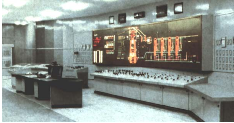
Система управления доменной печью на основе комплекса «МикроДАТ»
