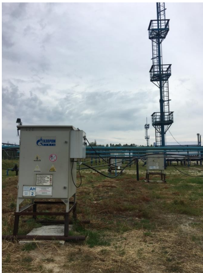
Рисунок 14 – Установка дозирования химического реагента
