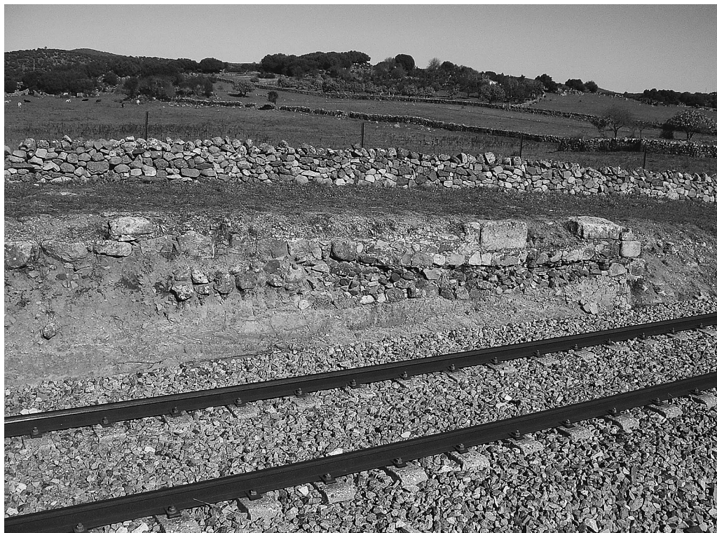
FIGURA 15 EDIFICIO CORTADO POR LA VÍA FÉRREA
