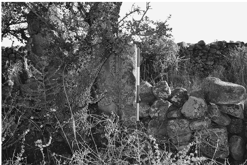
FIGURA 13 RESTOS ARQUITECTÓNICOS DE LA FUENTE DEL ÁLAMO
