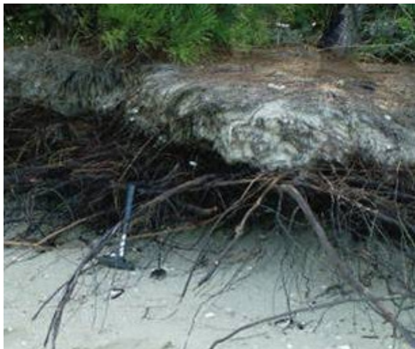
Figura 8. Socavamiento producto a la erosión del sustrato arenoso encontrado en la parte central de la costa norte de Cayo Moa Grande.
