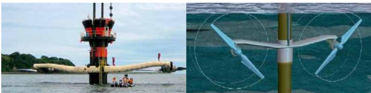
Abbildung 4: SeaGen, die erste kommerzielle Unterwasser-Stromfabrik in der Meerenge von Strangford in Nordirland ist eine Weiterentwicklung des SeaFlows (in Betriebnahme: 2008) (Siemens, Pictures of the Future, 2010, S. 4)
