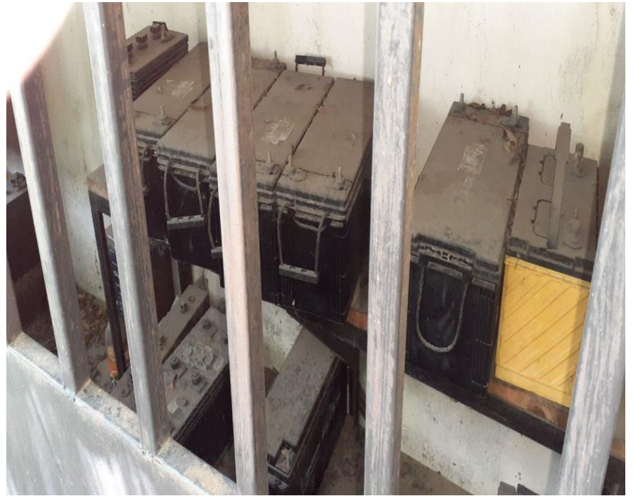
Baterías para almacenaje de energía producida por paneles fotovoltaicos en el laboratorio de aplicaciones de la escuela de ingeniería eléctrica de la Universidad de El Salvador
