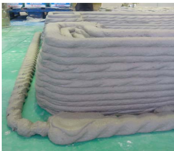
Figura 139. Procés de fabricació additiva de formigó. Font: pròpia.
