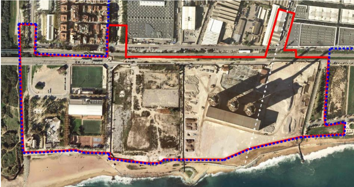
Ilustración 21. Estado actual del ámbito de las Tres Chimeneas. Fuente: Documentación gráfica PDU
