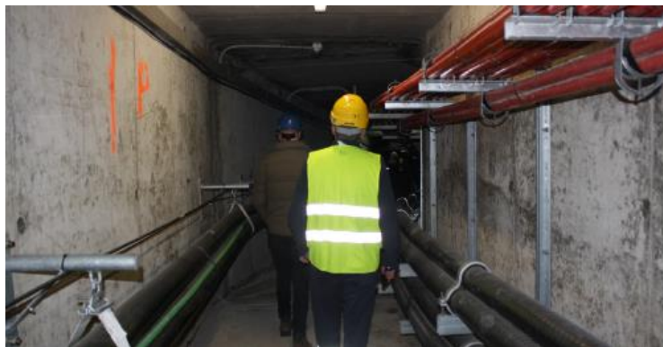
Ilustración 28. Galería de servicios. Fuente: Plataforma de conservación de las Tres Chimeneas.
