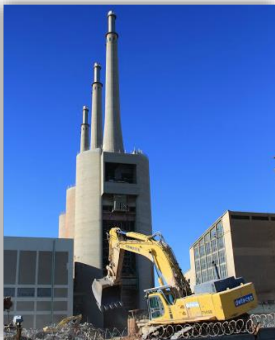
Ilustración 20. Desmantelamiento de las Tres Chimeneas. 2012. Fuente: Plataforma para la conservación de las Tres Chimeneas
