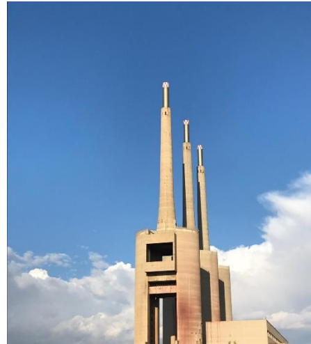
Ilustración 11. Conjunto de las Tres Chimeneas y la sala de turbinas. Fuente: Elaboración propia
