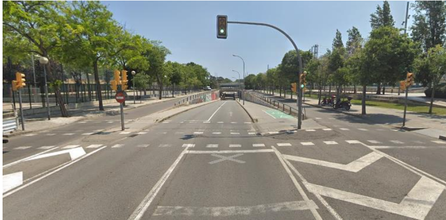
Ilustración 70. Punto de distribución del tráfico por arriba y por abajo. Fuente: Google Maps
