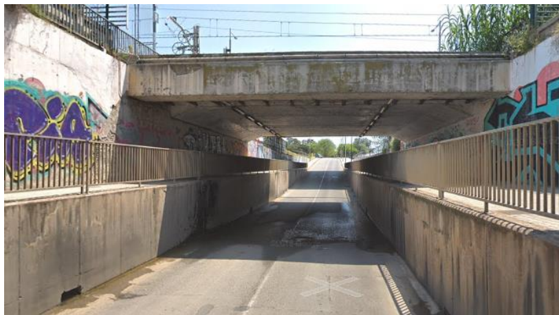
Ilustración 71. Vista del paso subterráneo. Fuente: Google Maps
