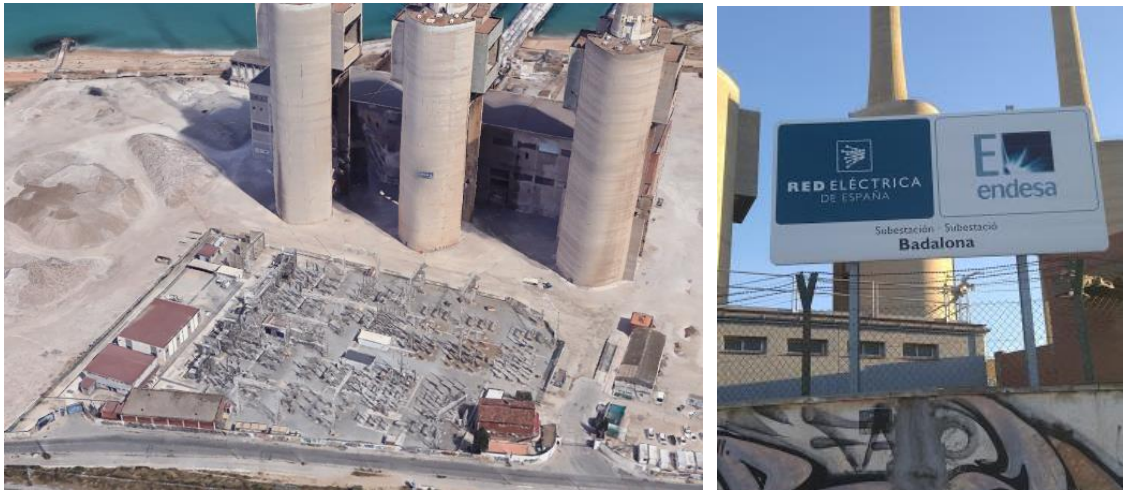
Ilustración 26. (Izquierda) Localización de la subestación de Badalona en el ámbito del PDU. Fuente: Google Earth
