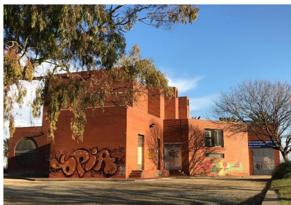
Ilustración 35. (Arriba) Tramo del colector a la altura de las Tres Chimeneas. (Abajo) Estación de bombeo ubicada dentro del parque Litoral. Fuente: Elaboración propia
