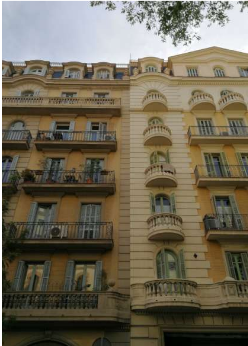
Figura 8: Vista exterior de la pared medianera del edificio
