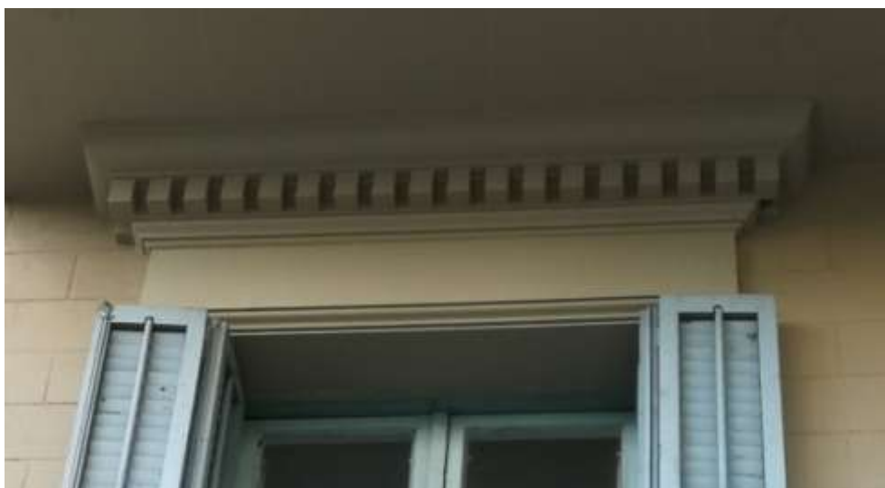
Figura 9: Vista exterior del dintel de una apertura de la fachada delantera
