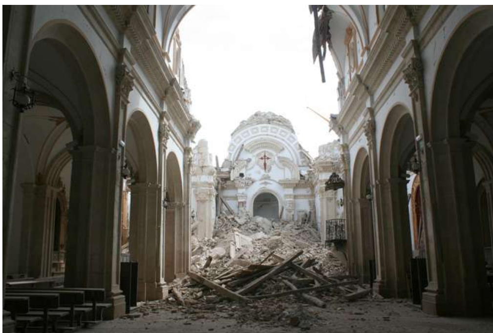
Figura 12: Iglesia de Santiago tras el terremoto de Lorca en 2011 (Fuente: B.A.B. Arquitectos)
