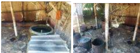
Gambar 2. Kondisi tempat pelorotan sebelumnya
