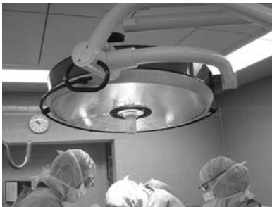
Figuur 12c: Voorbeeld van een ouderwets, mengend luchtbehandeling systeem waar geen downflow bestaat. Als er wel een neergaande luchtstroom vanuit het plafond zou zijn geweest, was die echter geheel tegengehouden door de grote, dichte lamp zonder aërodynamische vormgeving.
