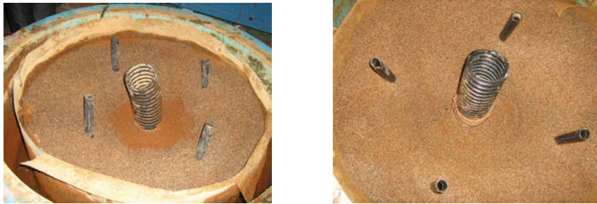
Рис. 6. Прифильтровая зона скважины до и после регенерации
