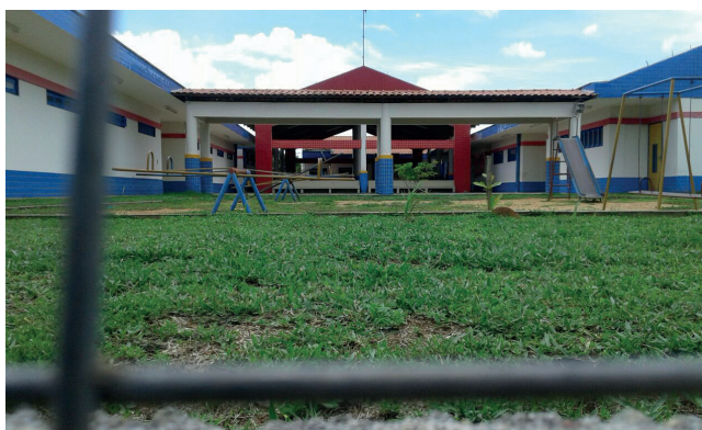
Figura 3: Vista da creche do município de Brejinho de Nazaré (TO). Silva (2017)
